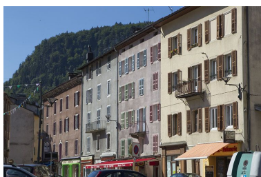
Elévation des bâtiments bordant le côté ouest. Phot. Yves Sancey IVR43_20103900681NUC2A
