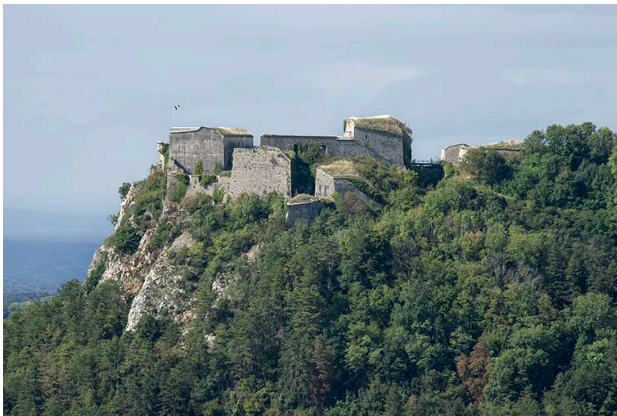
Fort Belin : vue générale du front sud.
