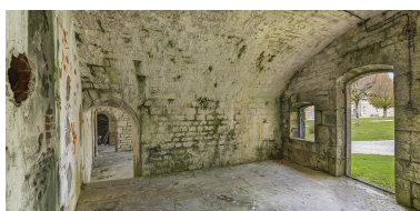
Fort Saint-André : pièce casematée. Phot. Thierry Kuntz IVR43_20213900347NUC4A
