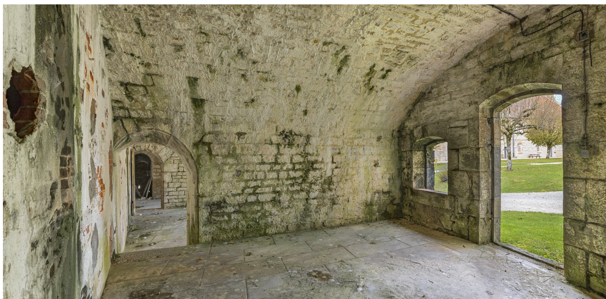
Fort Saint-André : pièce casematée.
