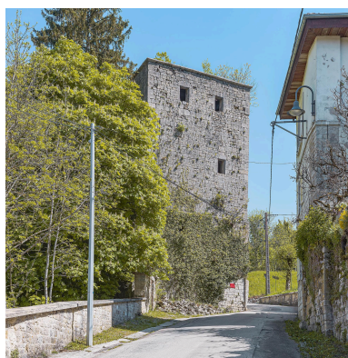
Bourg : la tour Chambenoiz. Phot. Thierry Kuntz IVR43_20223900606NUC4A
