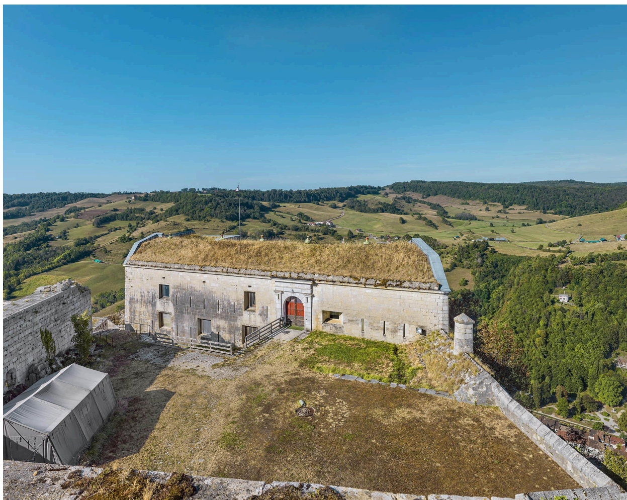
Fort Belin : le réduit.
