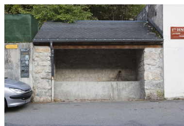
Fontaine-lavoir au 33 rue Wladimir Gagneur. Phot. Yves Sancey IVR43_20093900116NUC2A
