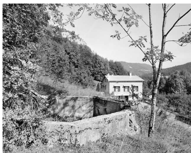
Réservoir au Pré vif. Phot. Yves Sancey IVR43_20033900925X
