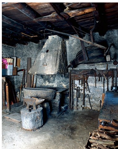
Vue générale de l'intérieur de la forge. Phot. Jérôme Mongreville IVR43_19943900816XA
