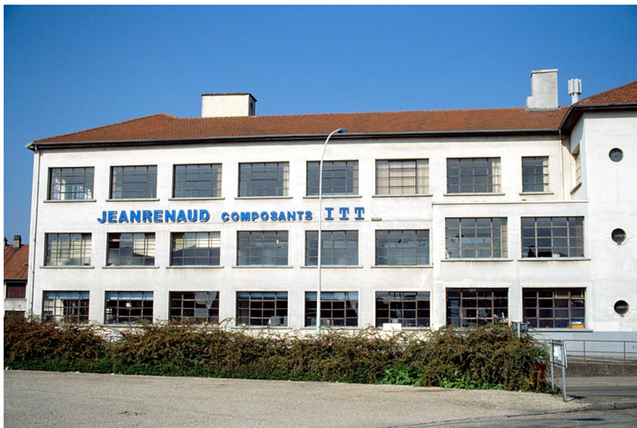
Usine 1 : façade antérieure de l'aile (B).
