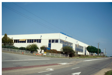
Usine 3, vue de trois quarts gauche. Phot. Laurent Poupard IVR43_19893900274ZA
