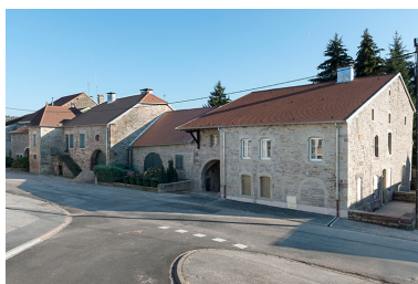
Vue d'ensemble. Phot. Sonia Dourlot IVR43_20157001206NUC4A
