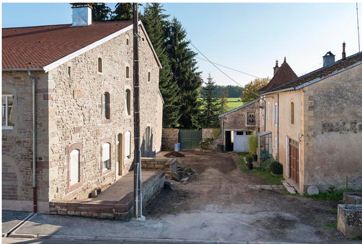
Vue du mur pignon ouest.
