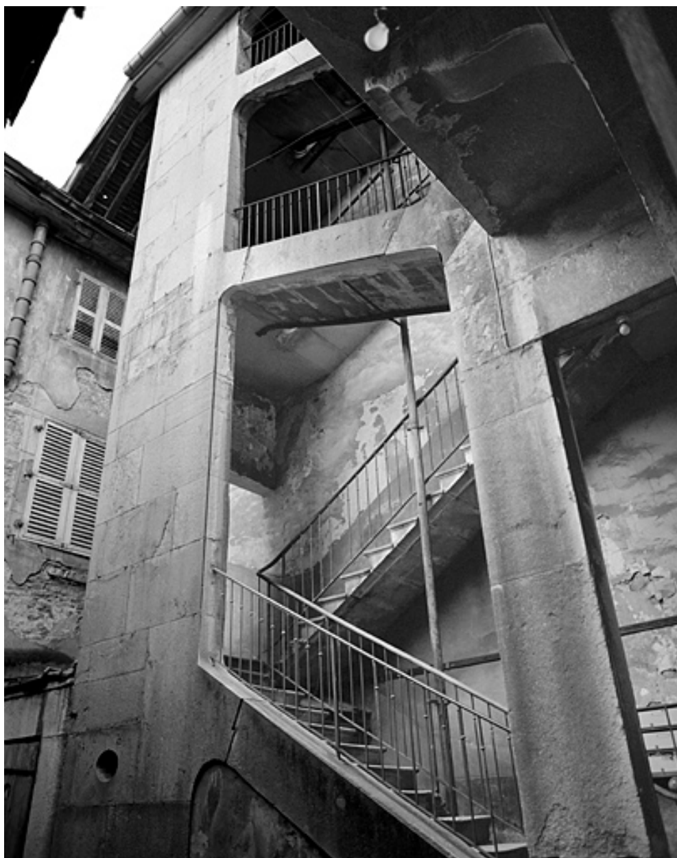
Maison, 16 rue Regard, escalier sur cour.
