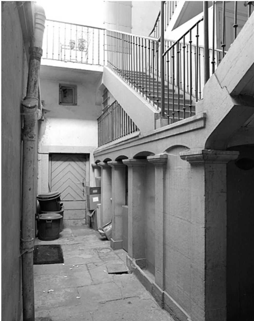
Maison, 58 rue du Commerce, escalier sur cour.
