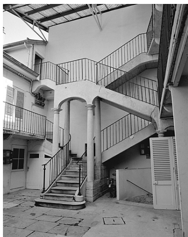
Maison, 74 rue Saint- Désiré, escalier sur cour. Phot. Yves Sancey IVR43_19833900245X
