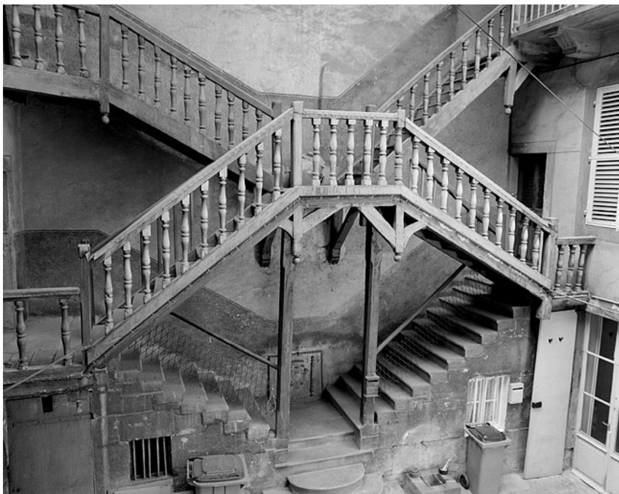
Maison, 17 rue Saint-Désiré, escalier sur cour.
