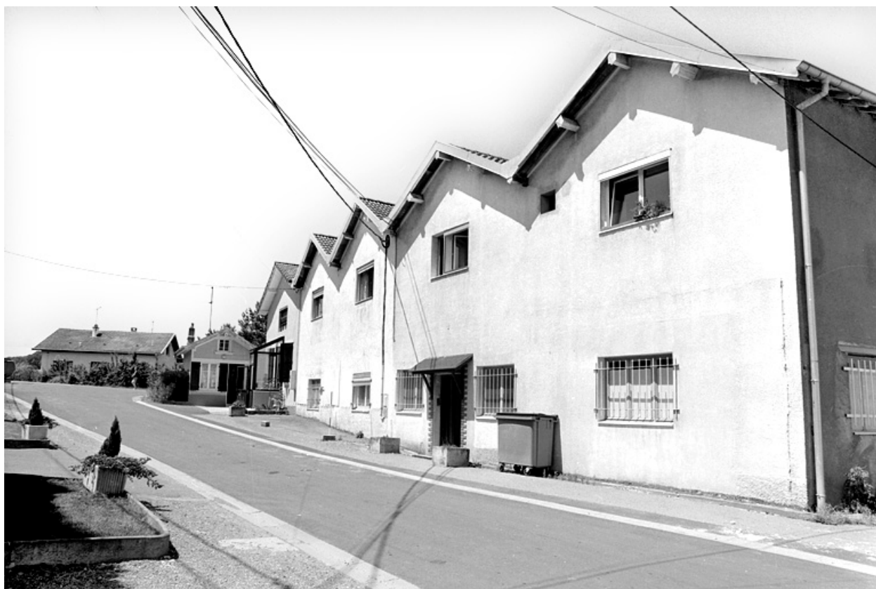
Murs-pignons des ateliers de fabrication.
