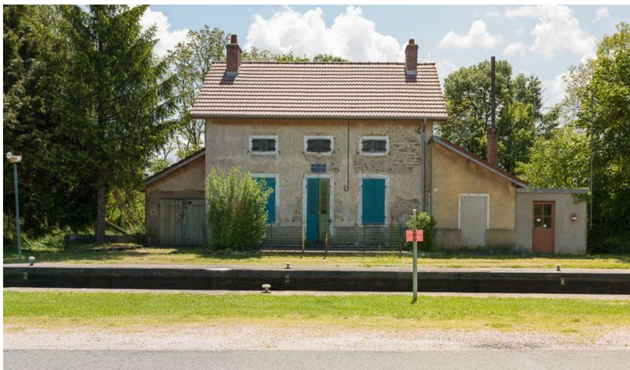
Vue de face de la maison éclusière.
