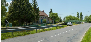
Vue d'ensemble. Phot. Pierre-Marie Barbe-Richaud IVR26_20137100455NUC4AQ
