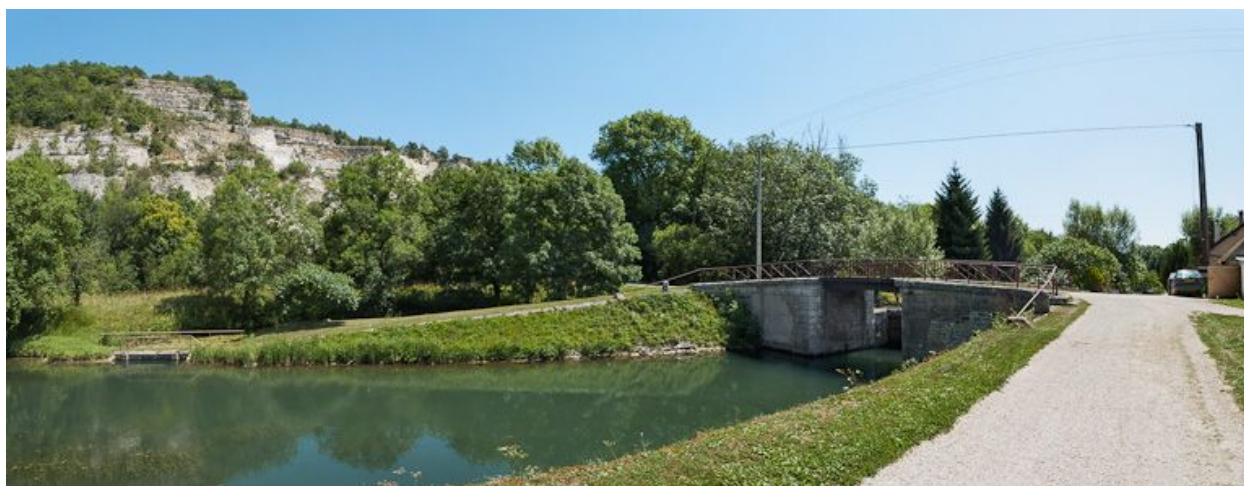
Pont vu d'aval.
