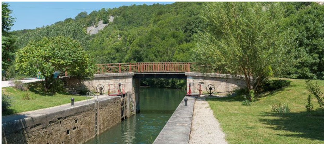
Pont vu du sas.
