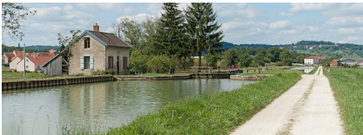
Vue du site d'écluse depuis l'amont.
