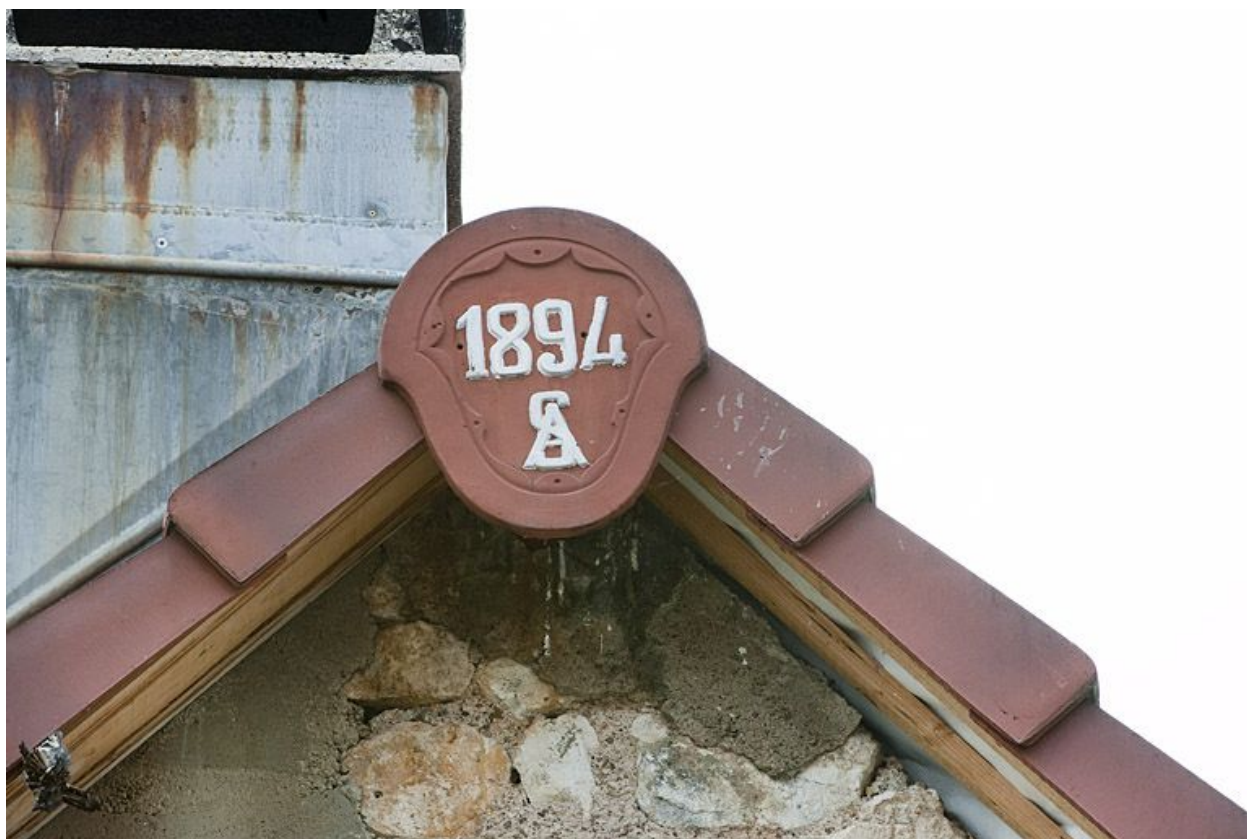
Antéfixe d'une maison (rue de la Gaieté).
