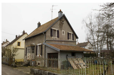
Maison individuelle rue du Chardonneret. Phot. Marc Loukachine IVR43_20122500231NUC2A
