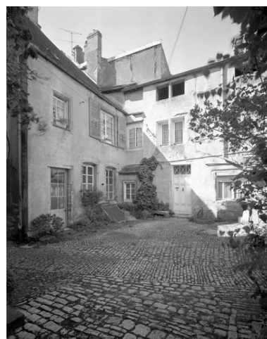
Façades sur cour : vue d'ensemble. Phot. Yves Sancey IVR43_19897000487V
