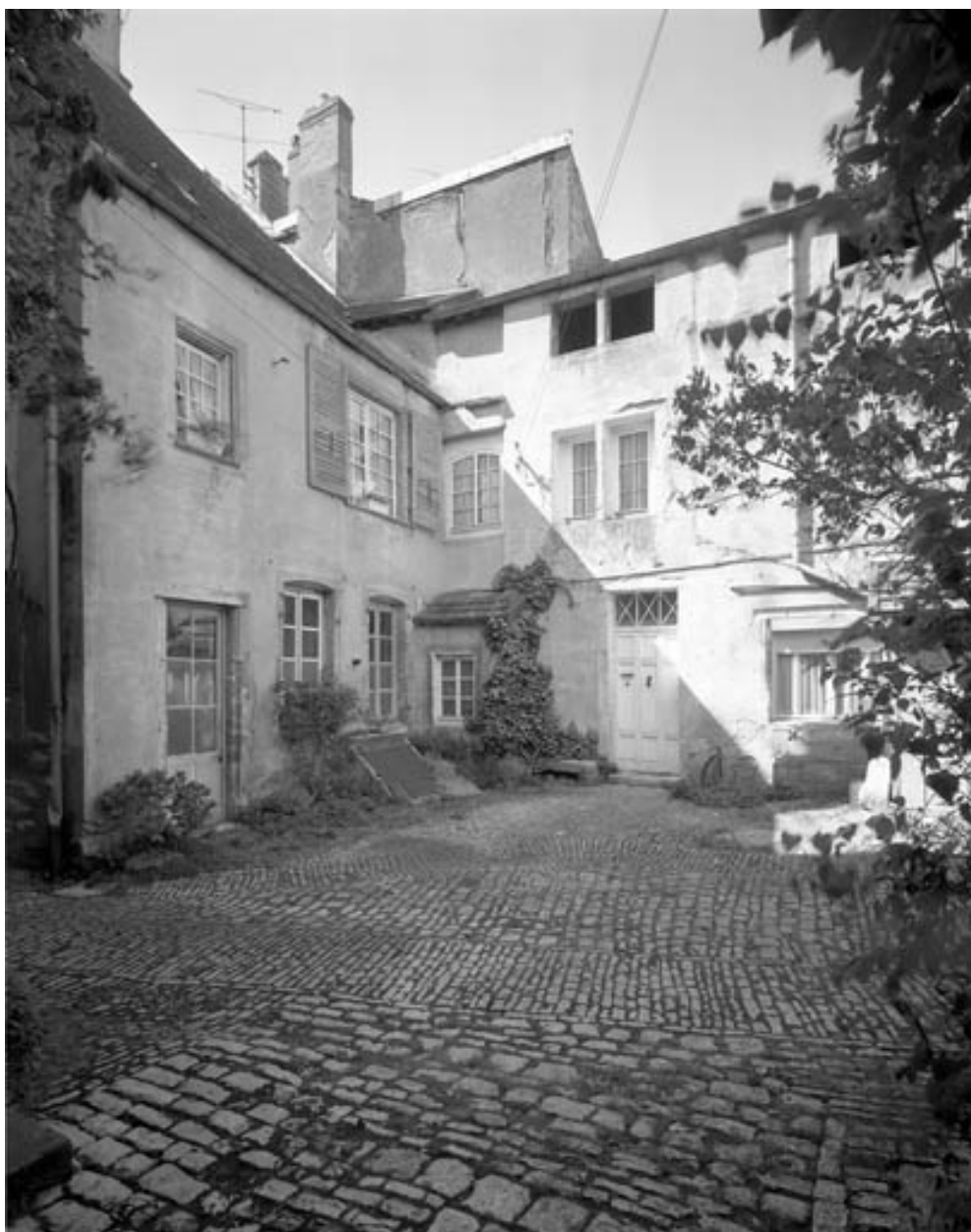
Façades sur cour : vue d'ensemble.
