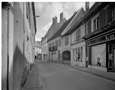
Façade sur rue de trois quarts droit. Phot. Yves Sancey IVR43_19897000481V
