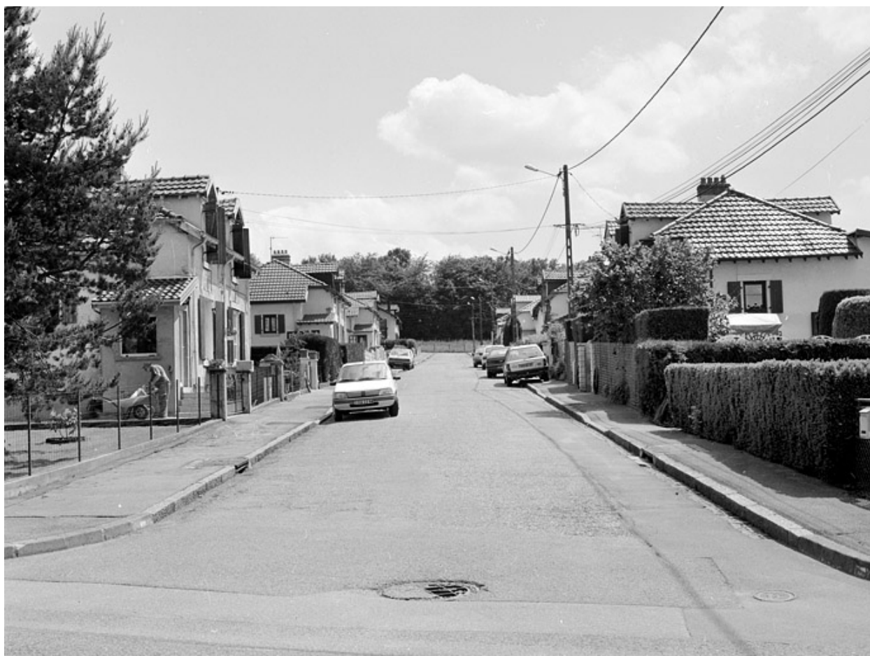
Vue de la rue de Flandre.
