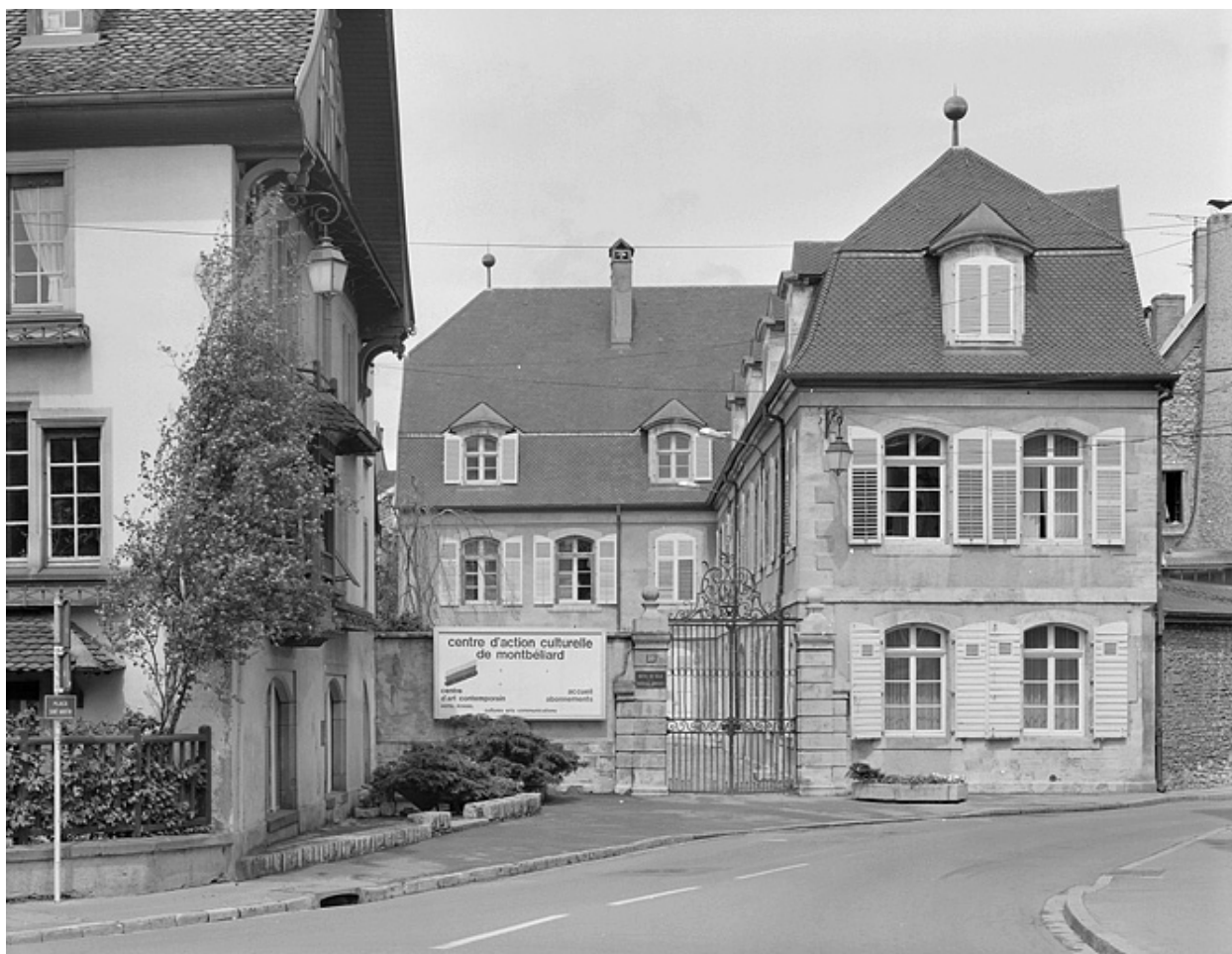
Vue d'ensemble depuis la place Saint-Martin.
