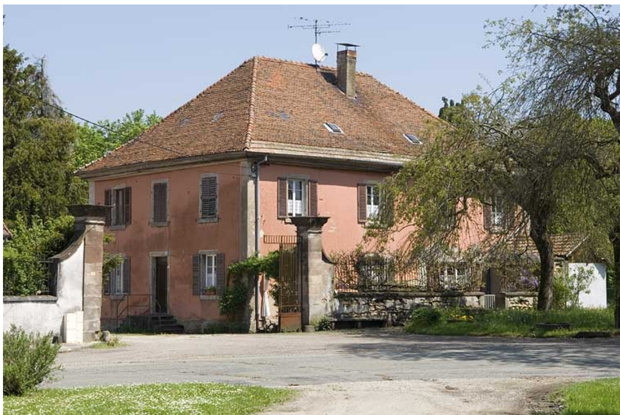
Bâtiment des bureaux (direction).
