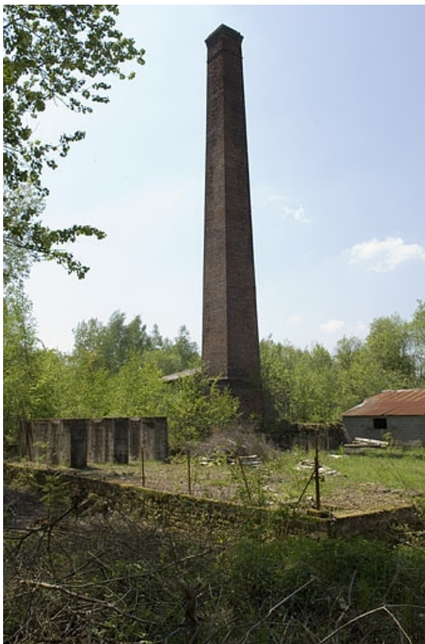
La cheminée vue depuis le nord-est.
