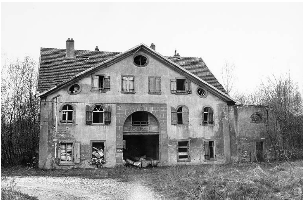
Bâtiment d'entrée ouest en 1977. Façade antérieure.
