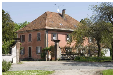
Bâtiment des bureaux (direction).
