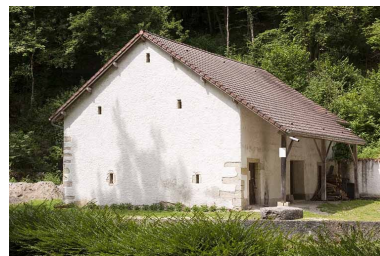
Dépendance agricole. Phot. Jérôme Mongreville IVR43_20112501299NUC4A
