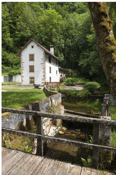
Vue rapprochée depuis l'aval. Phot. Jérôme Mongreville IVR43_20112501289NUC4A
