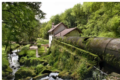
La conduite d'amenée couverte et le moulin vus depuis la source. Phot. Jérôme Mongreville IVR43_20112501296NUC4A
