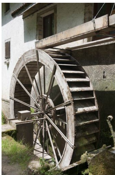
Roue hydraulique et sa huche. Phot. Jérôme Mongreville IVR43_20112501292NUC4A
