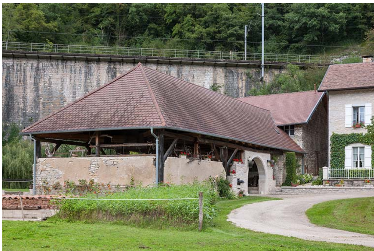
Bâtiment des dépendances depuis le sud-est.
