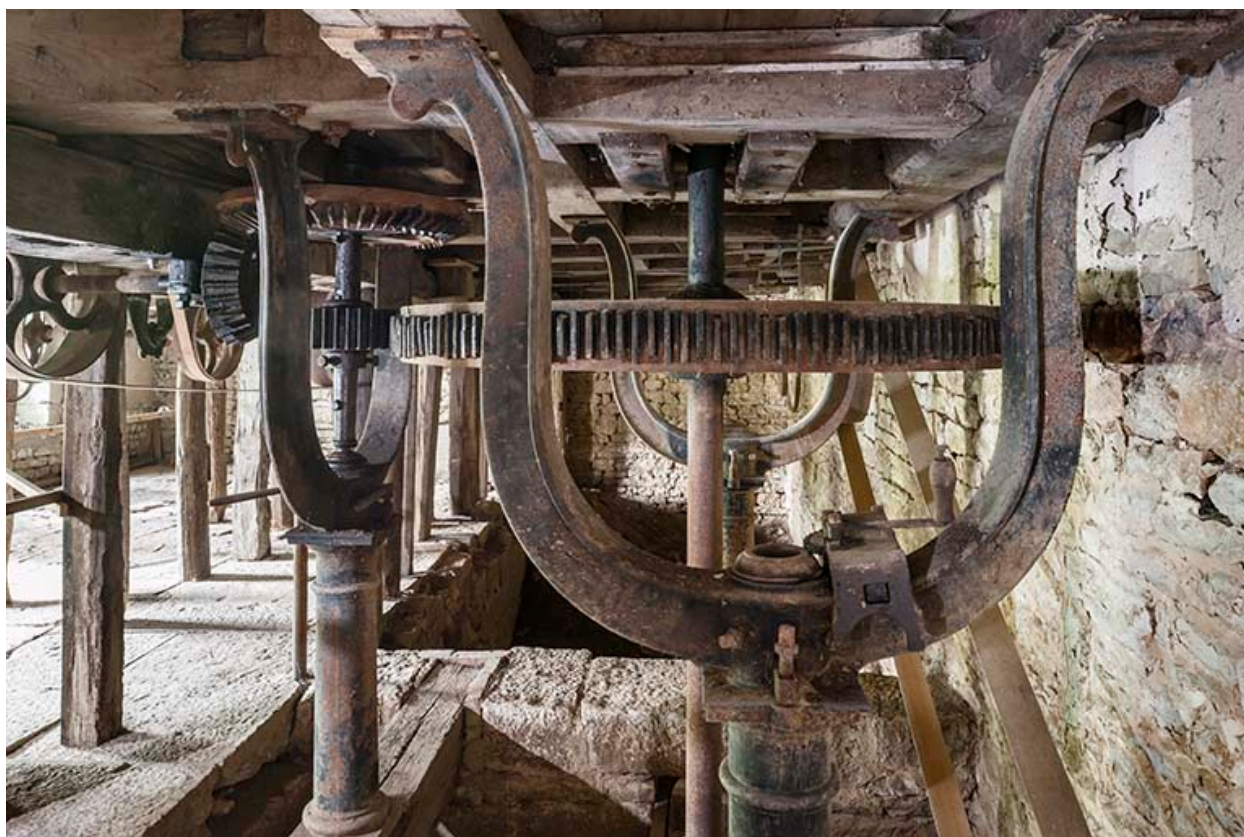
Etage de soubassement. Beffroi du moulin.
