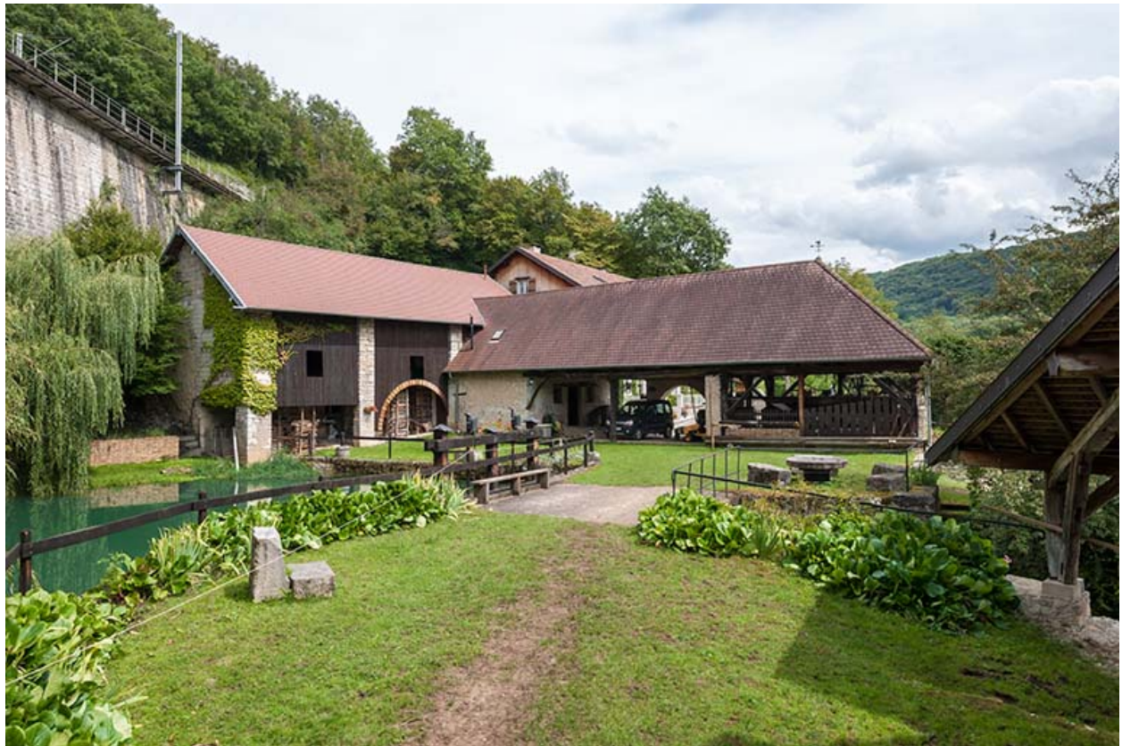
Grange, écurie et remise depuis l'ouest.
