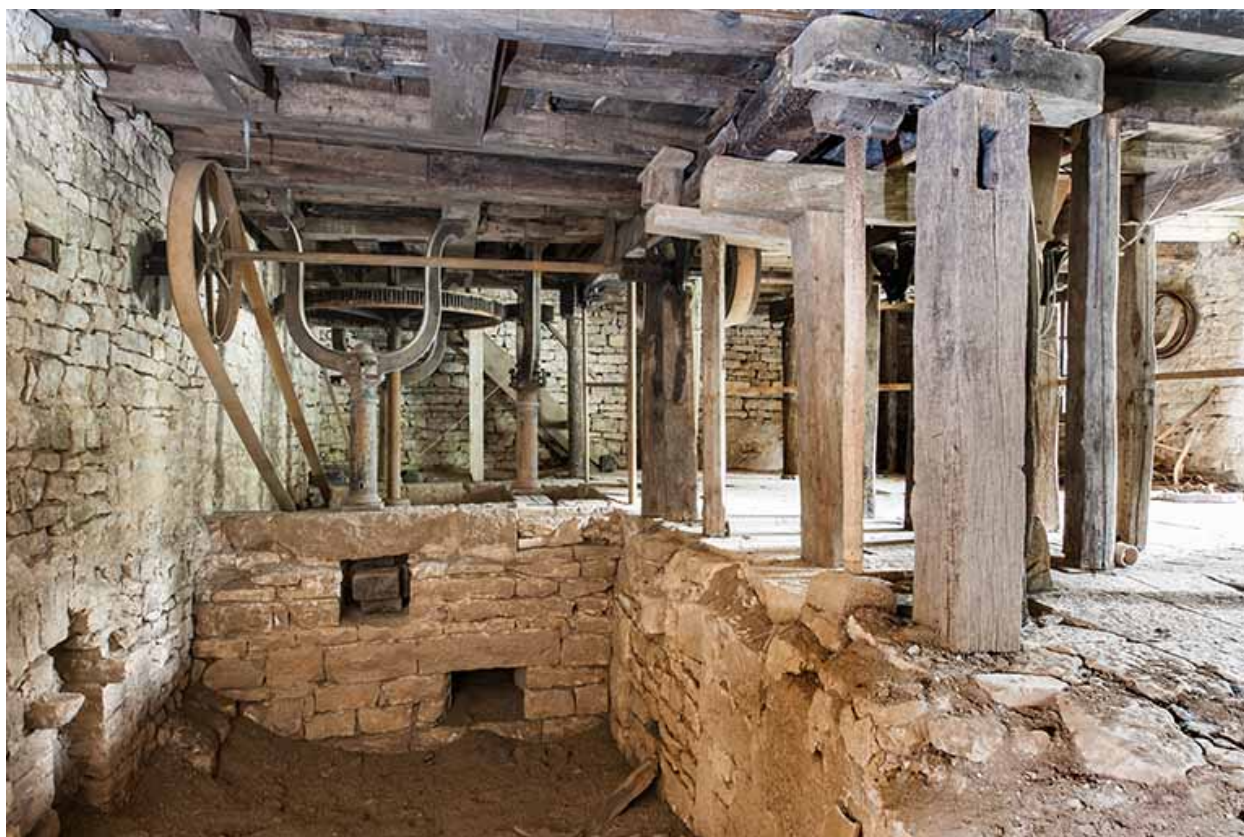
Etage de soubassement. Vue depuis l'ouest.
