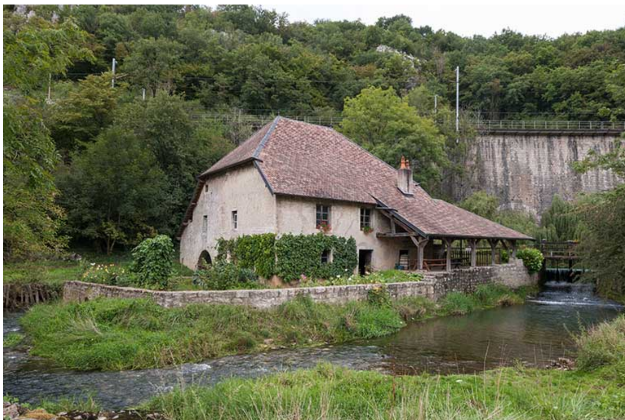
Vue rapprochée du moulin depuis le sud-ouest.
