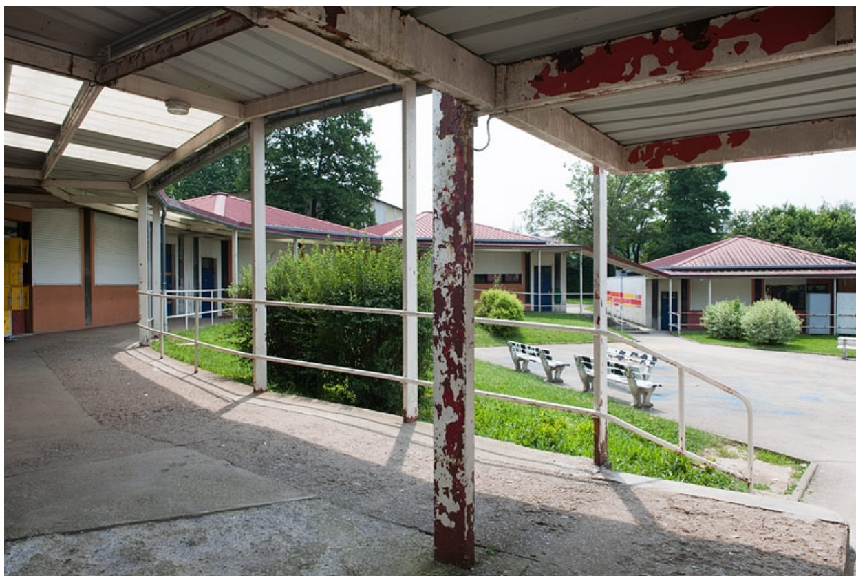
Vue générale de la galerie couverte.
