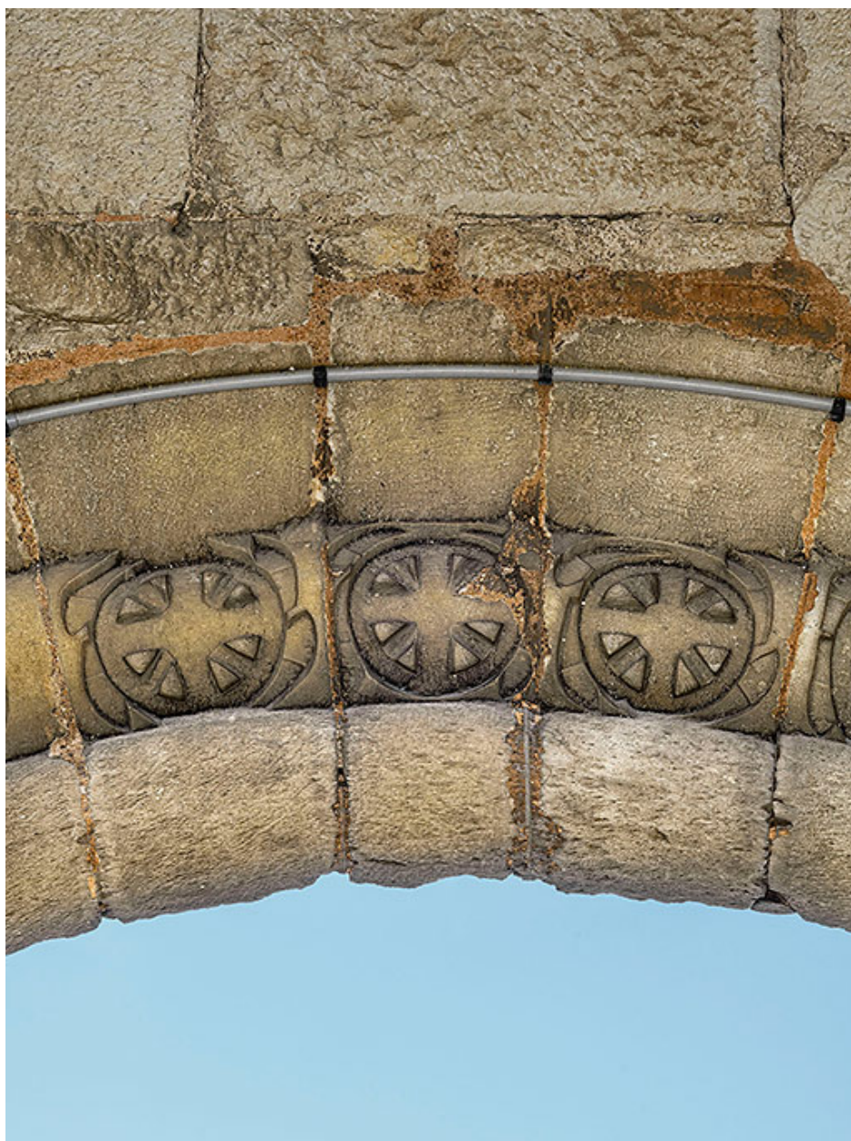
Rouelles sculptées, voûte du passage.
