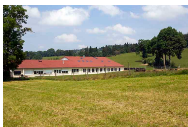
Façade postérieure (sud), de trois quarts gauche.
