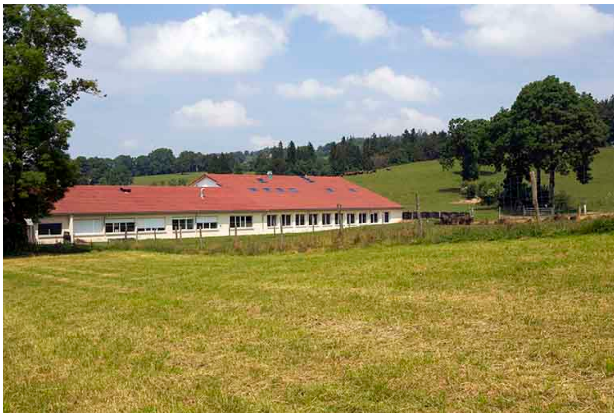
Façade postérieure (sud), de trois quarts gauche.
