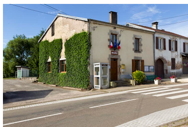
Façades antérieur et latérale gauche. Phot. Sonia Dourlot IVR43_20157001029NUC2A
