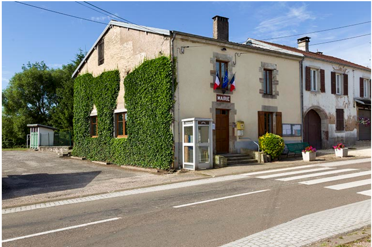
Façades antérieur et latérale gauche.
