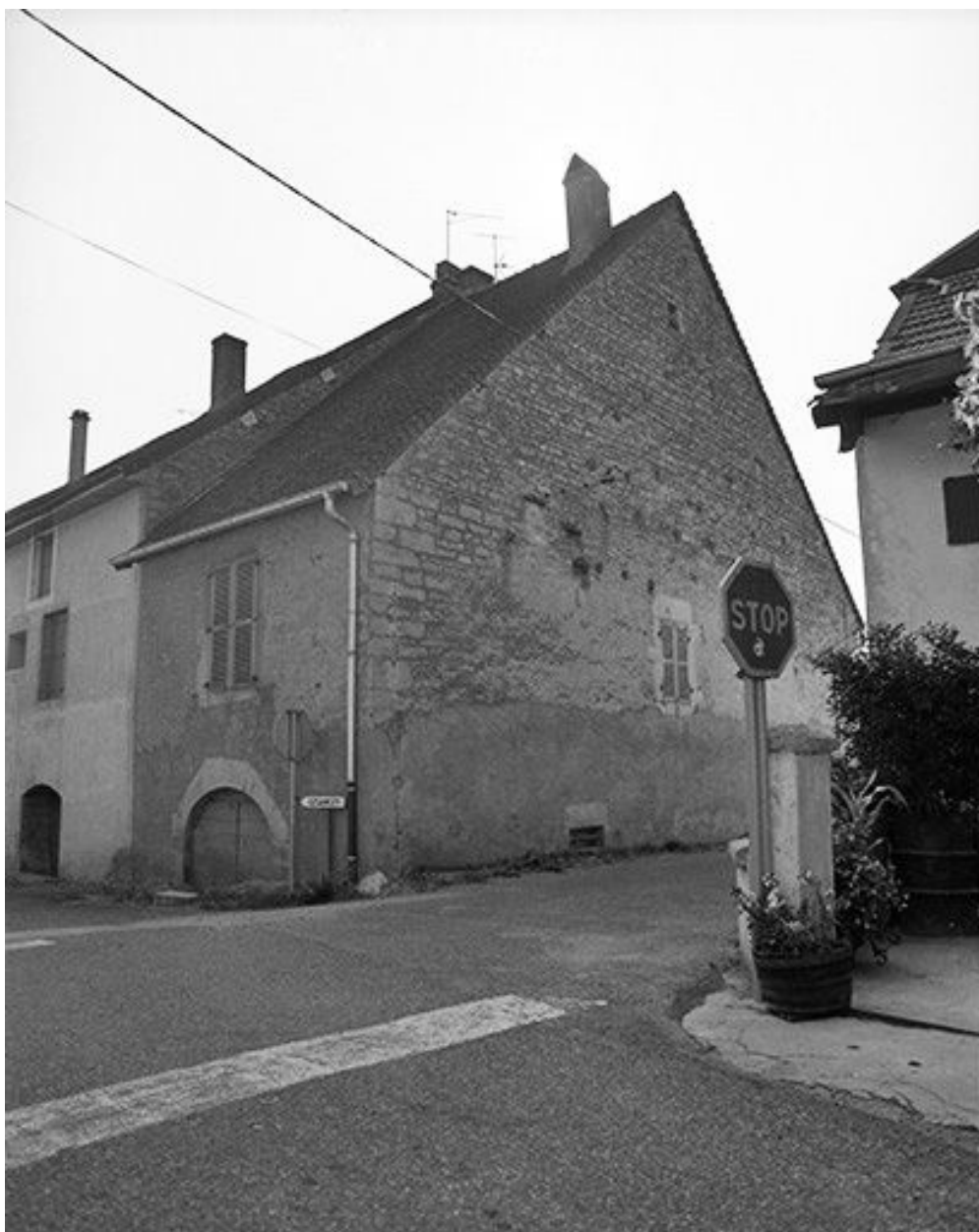
Face postérieure et pignon gauche.
