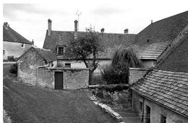
Façade sur cour. Phot. Bernard Lardière IVR43_19797000286Z
