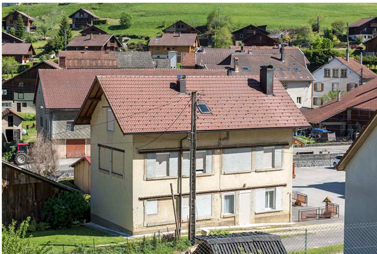
Façades postérieure et latérale gauche.
