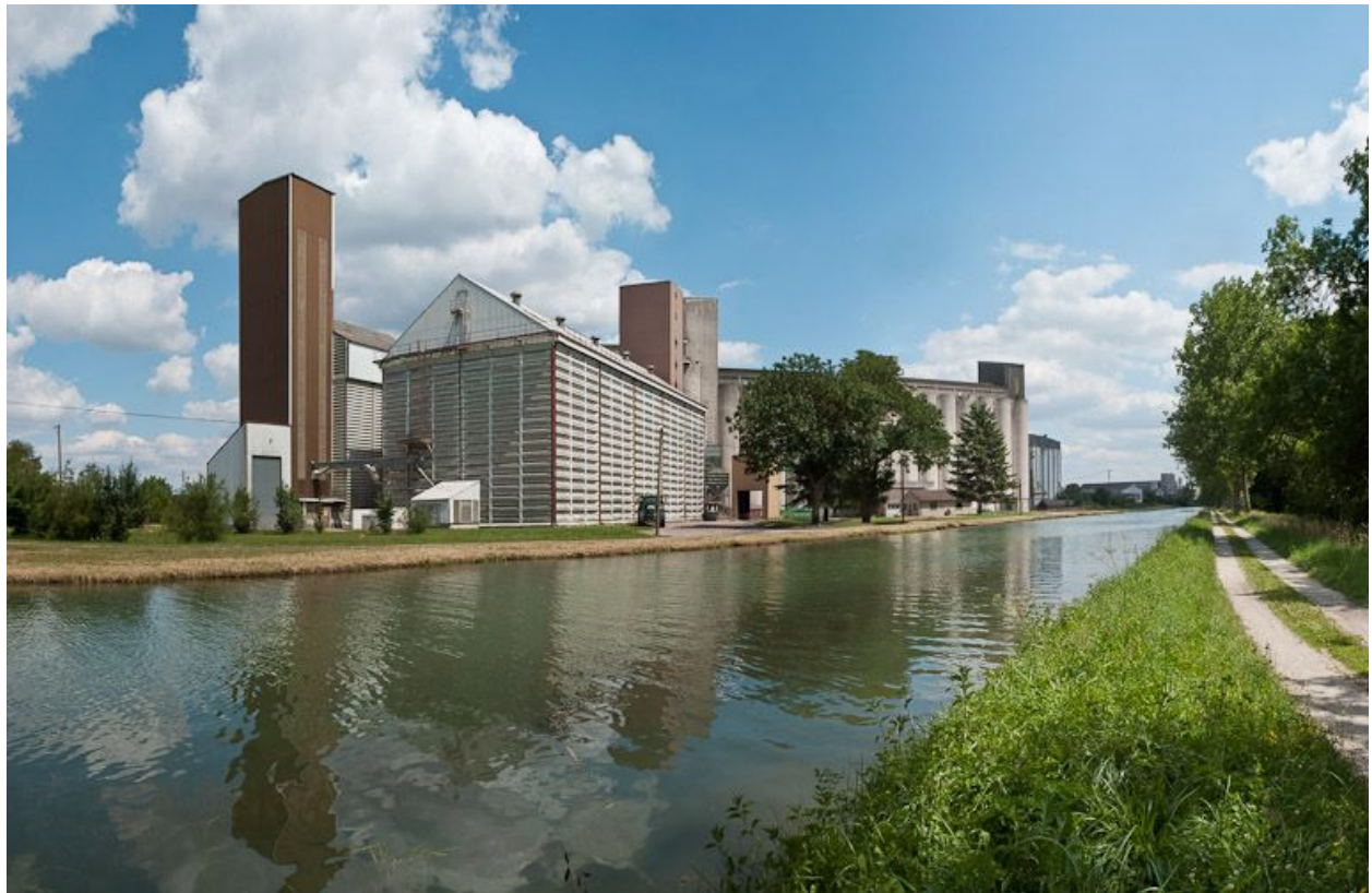
Vue des silos à Pacy-sur-Armançon.
