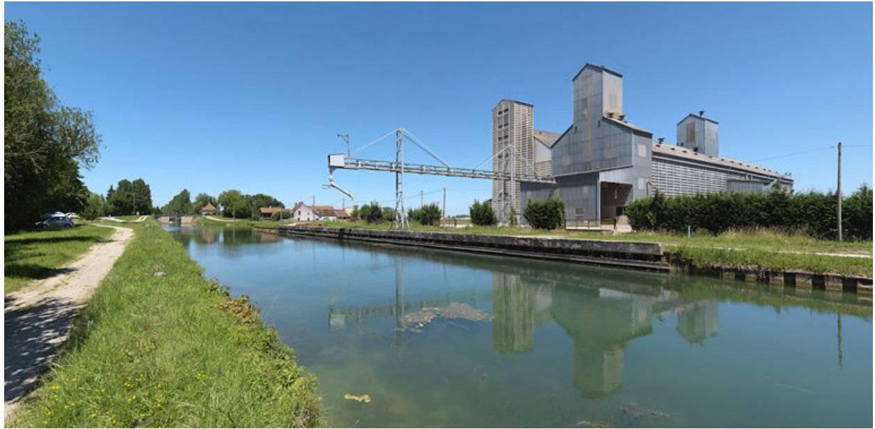
Silos à Longecourt-en-Plaine.
