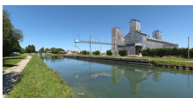
Silos à Longecourt-en-Plaine.
