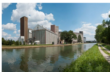
Vue des silos à Pacy-sur-Armançon.
