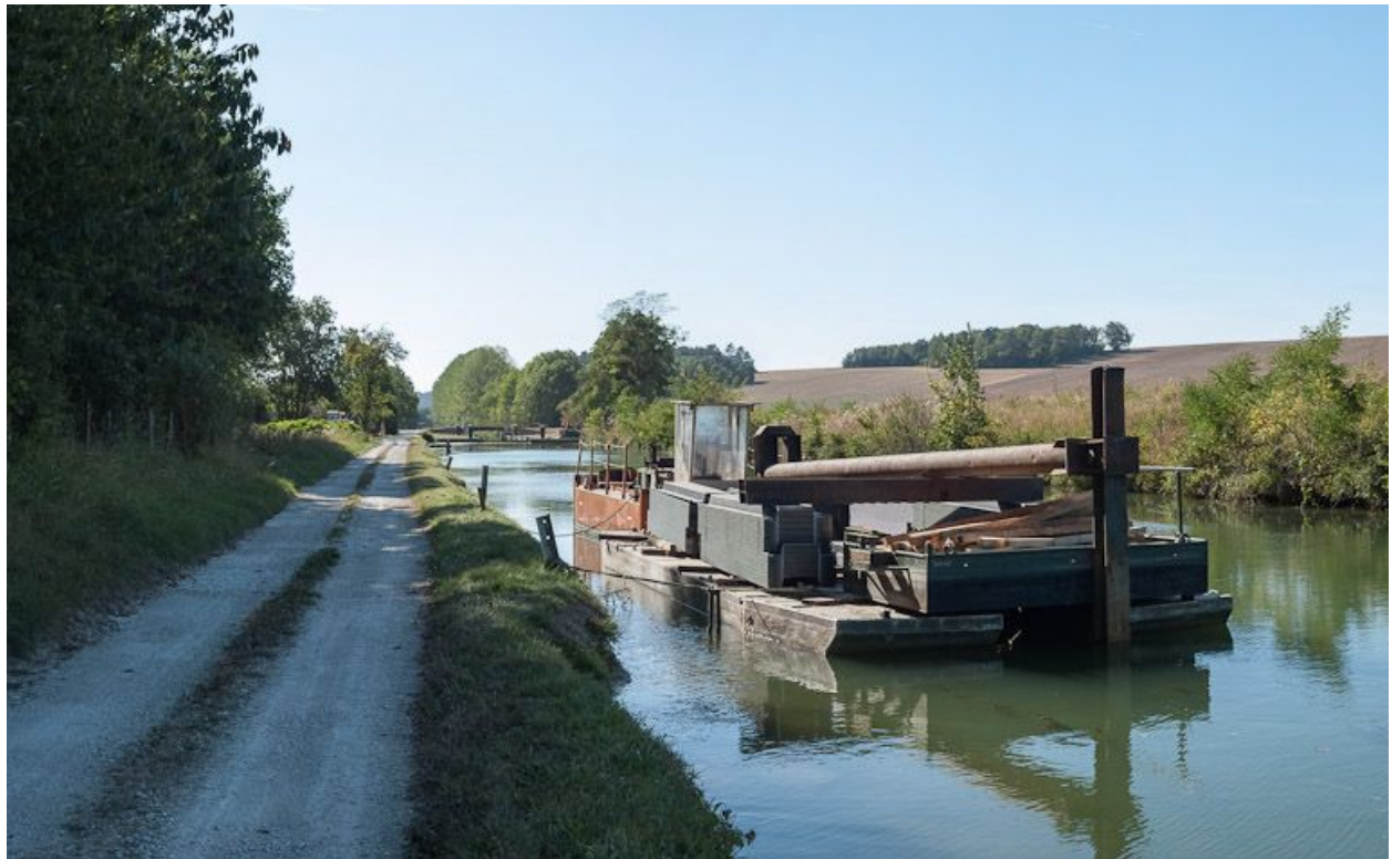
Barge de travaux sur palplanches à Ancy-le-Franc.
