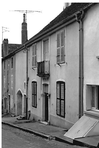
Façade antérieure. Phot. Dominique Dominguez IVR43_19807000518X
