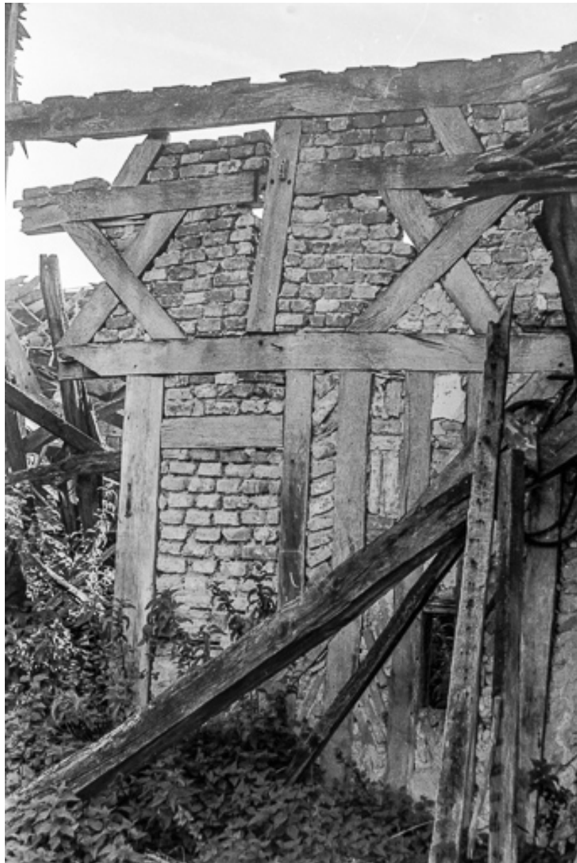
Ferme cadastrée 1956 A1 142-143 : détail du mur.
