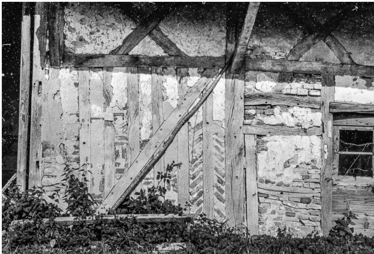
Ferme cadastrée 1956 A1 142-143 : détail du mur.
