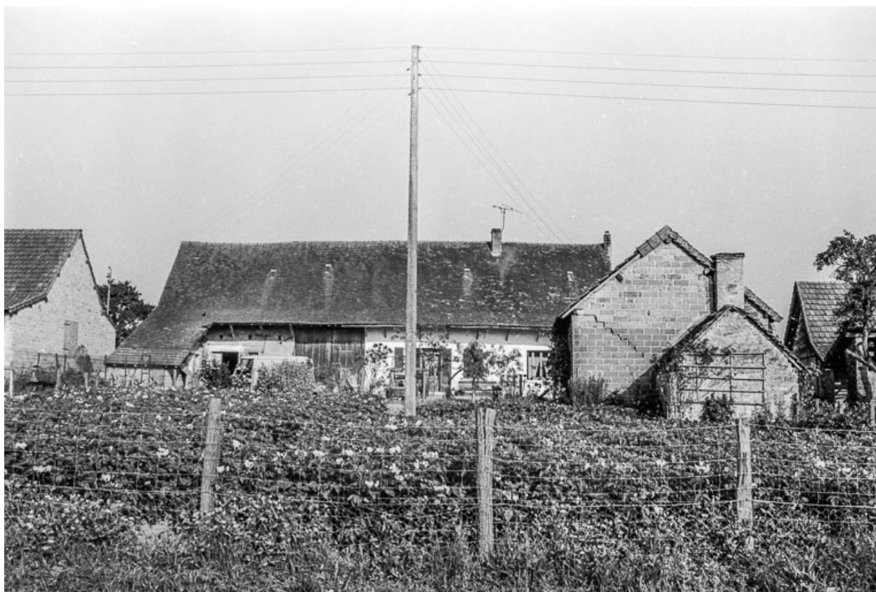
Ferme cadastrée 1956 A1 169 : façade antérieure.
