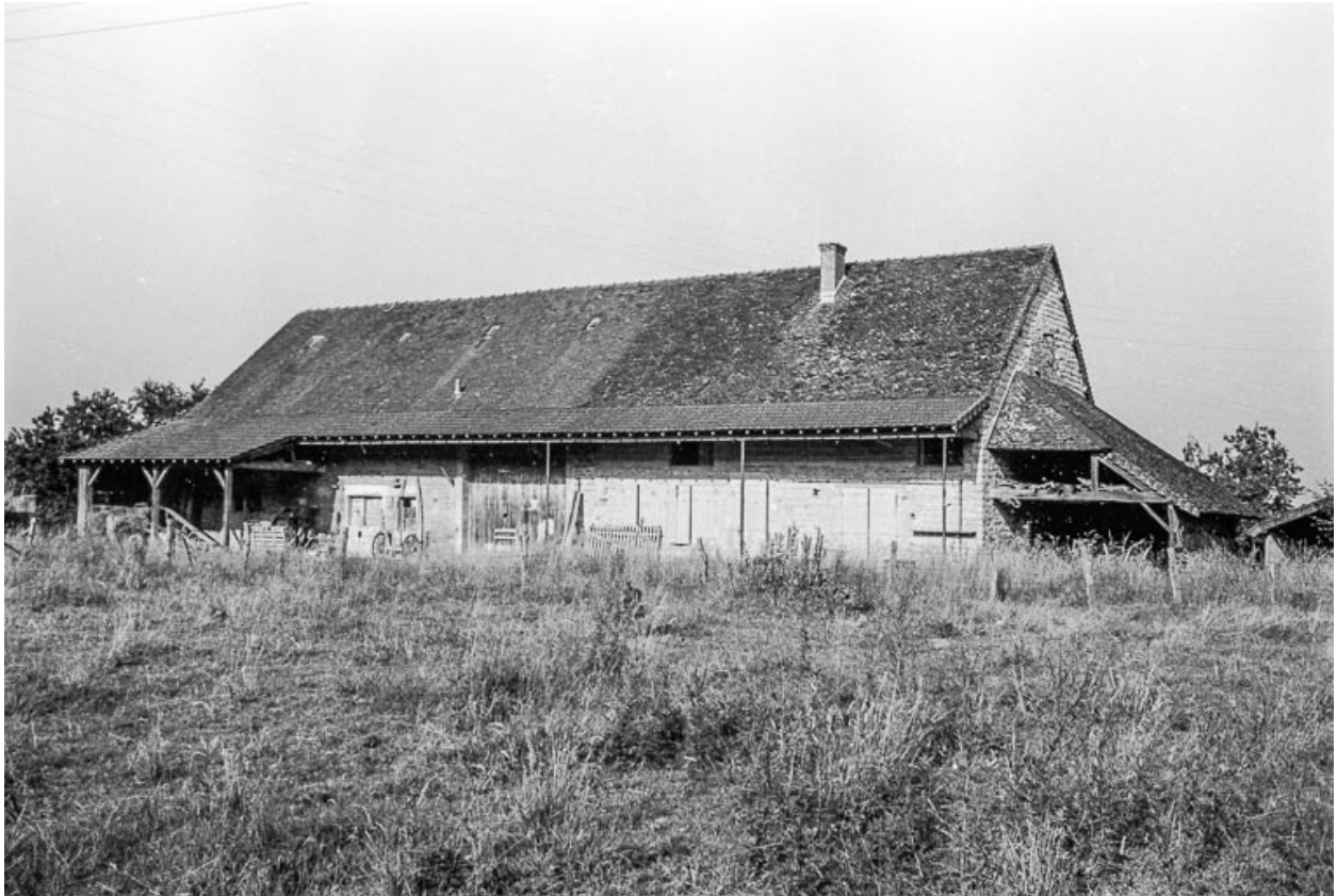
Ferme cadastrée 1956 A2 424 : façade antérieure.
