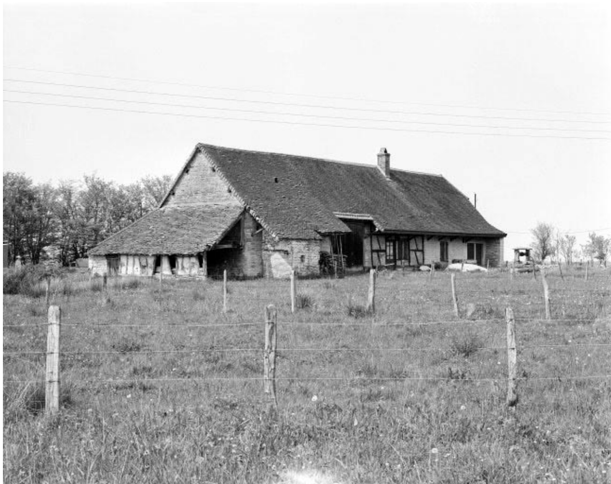
Ferme : vue générale.
