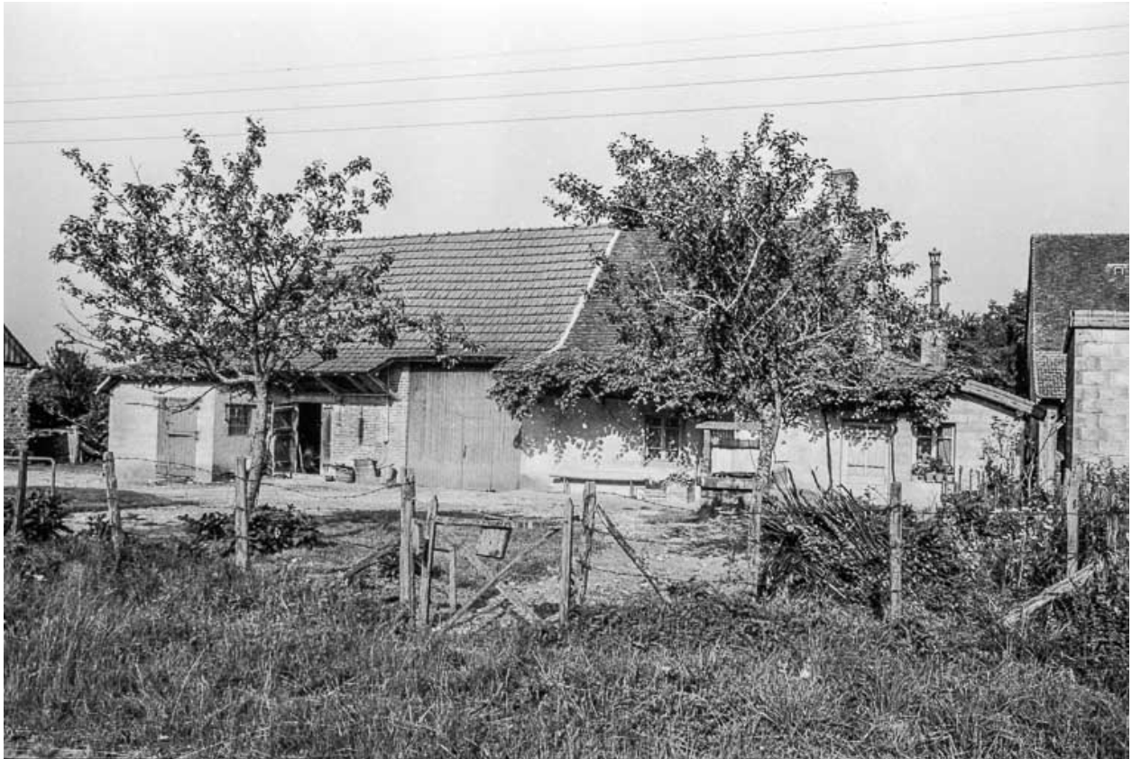
Ferme cadastrée 1956 A2 431 : façade antérieure.
