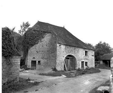
Ferme située 8 rue du Châtelet. Phot. Dominique Dominguez IVR43_19807000189X
