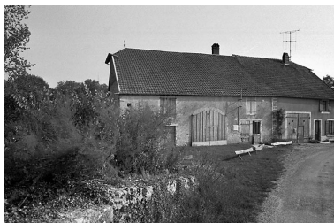
Ferme située rue du Pont. Phot. Dominique Dominguez IVR43_19807000195Z
