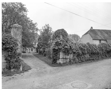
Ferme située rue du Châtelet. Phot. Dominique Dominguez IVR43_19807000179X
