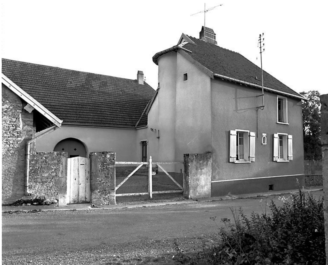
Ferme située 3 rue Montante.
