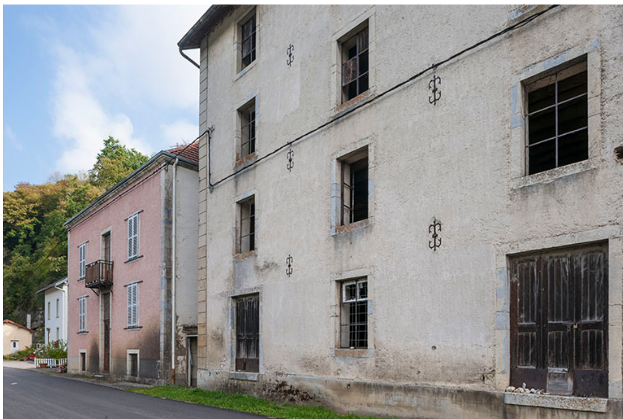
Le logement patronal et la façade ouest de la minoterie.
