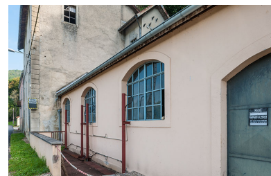
Vue rapprochée sur la centrale hydroélectrique. Phot. Jérôme Mongreville IVR43_20142501119NUC4A
