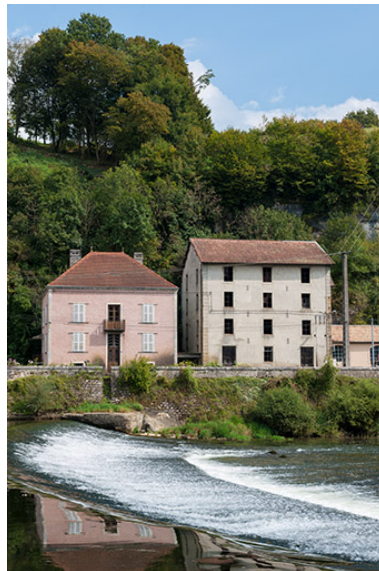
Le logement patronal et la minoterie depuis l'ouest. Phot. Jérôme Mongreville IVR43_20142501124NUC4A
