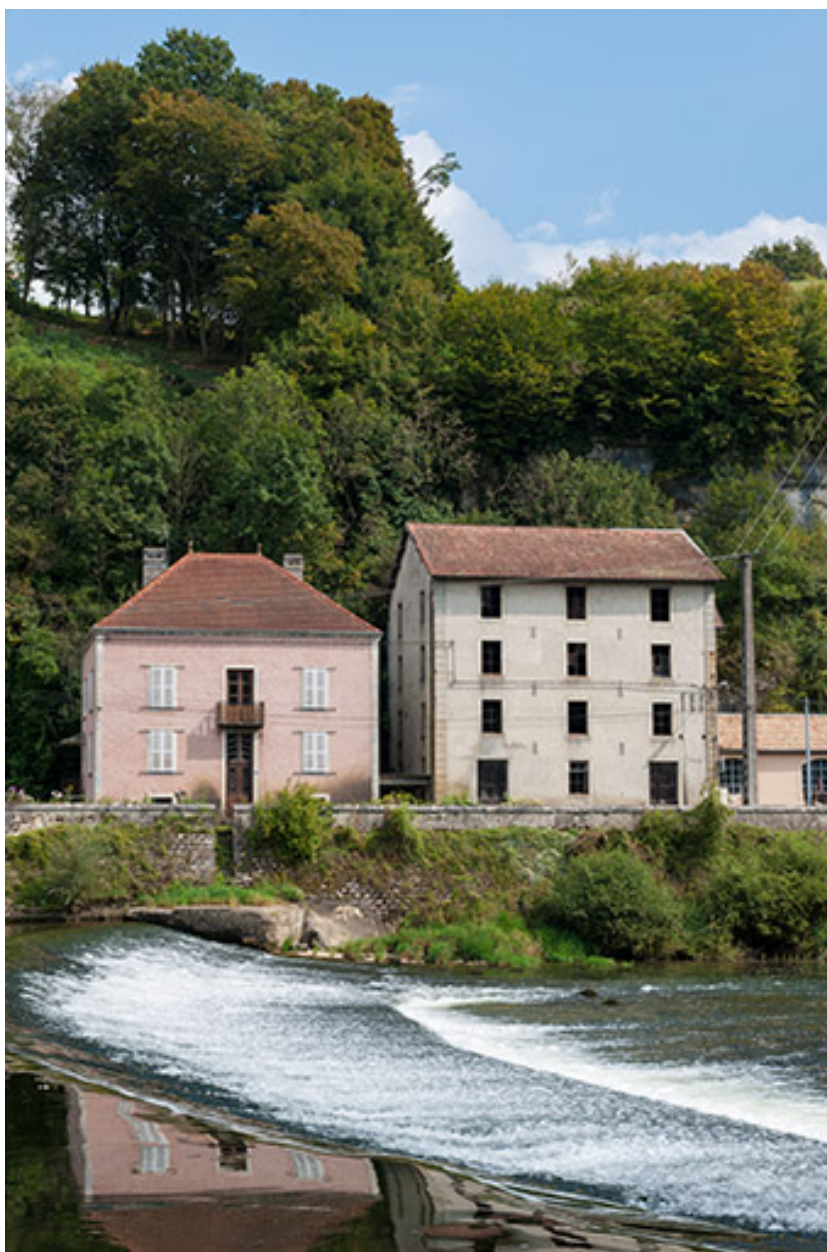
Le logement patronal et la minoterie depuis l'ouest.
