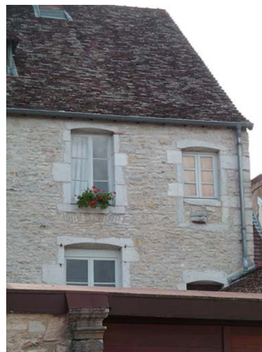
Détail des baies de l'étage Phot. Sabrina Dalibard IVR43_20137000803NUC2A
