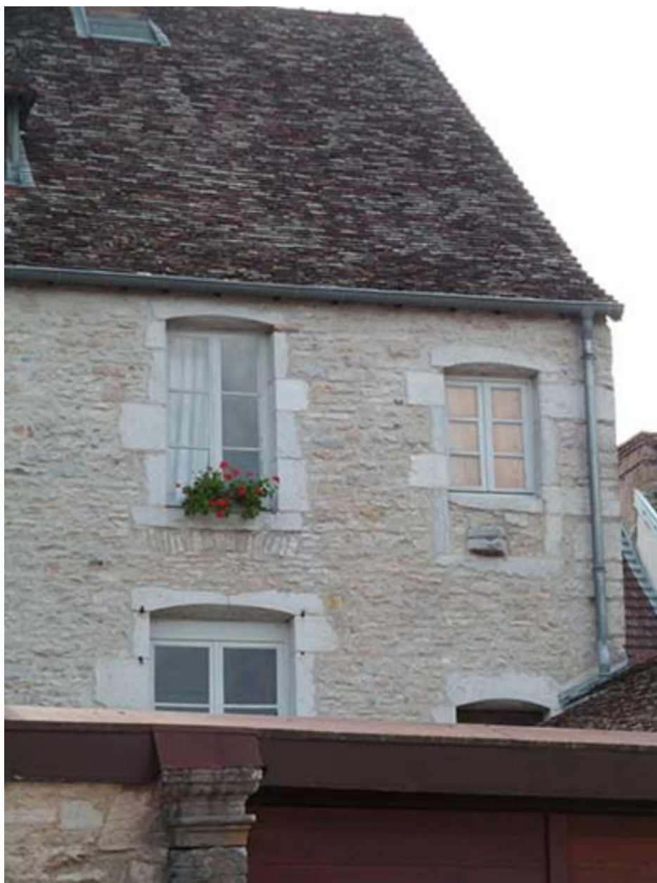
Détail des baies de l'étage
