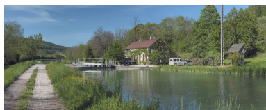
Vue d'ensemble de l'amont du site d'écluse. Phot. Thierry Kuntz IVR26_20122102444NUC4A
