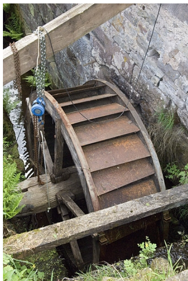
Vue plongeante sur la roue hydraulique. Phot. Jérôme Mongreville IVR43_20067000364NUCA
