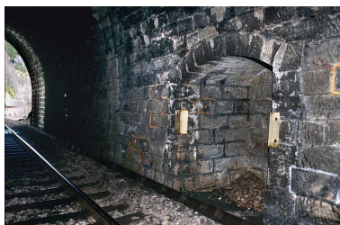
Tunnel du Champ de Bienne : refuge.
