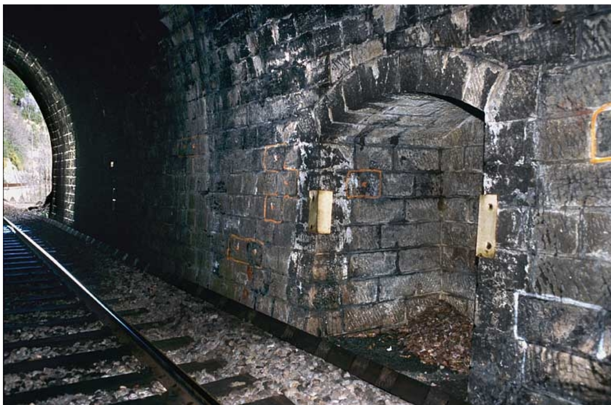
Tunnel du Champ de Bienne : refuge.
