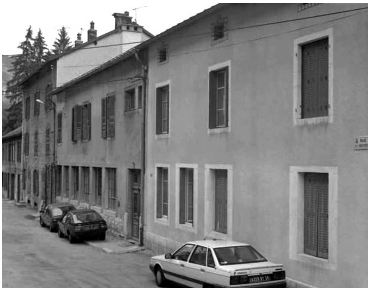
Façades sur la rue de l'Industrie.
