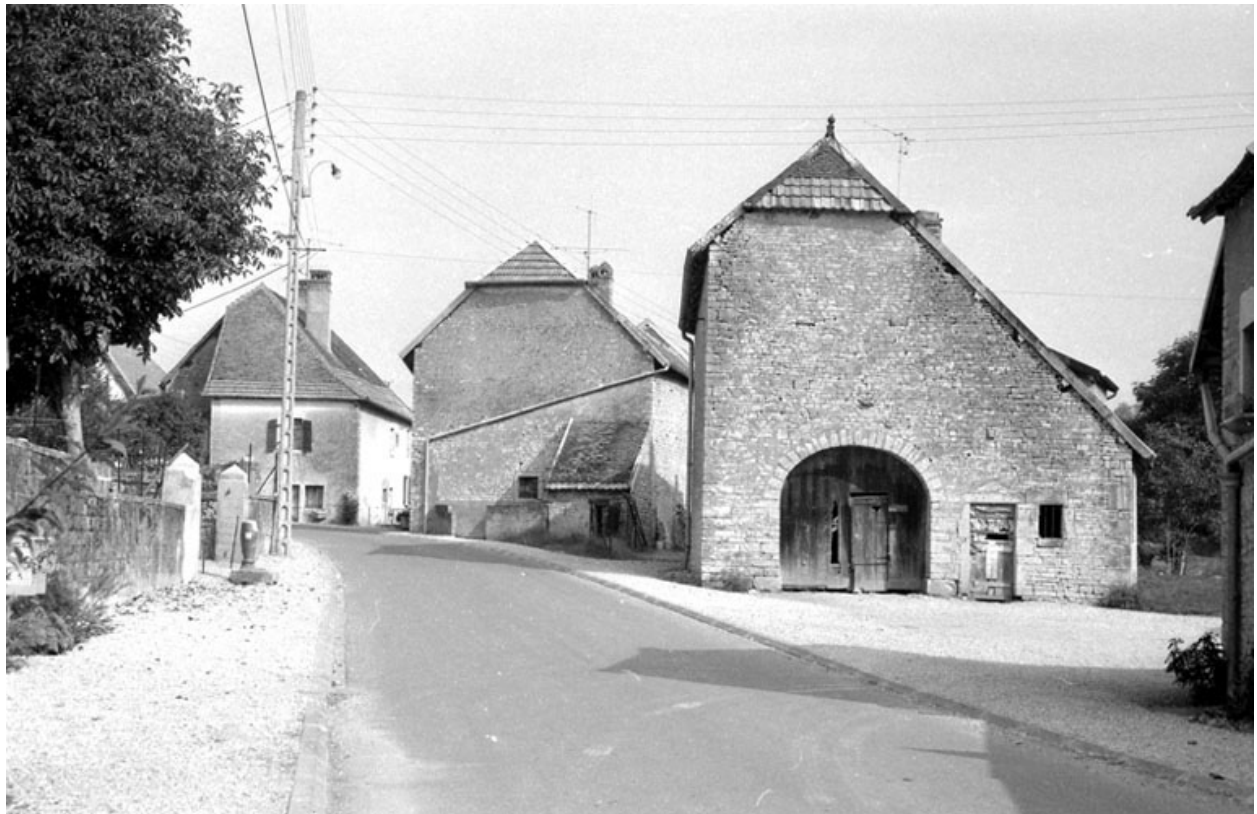
Façade latérale droite.
