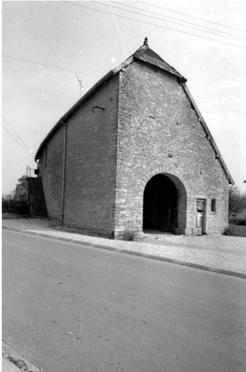
Façades antérieure et latérale droite.
