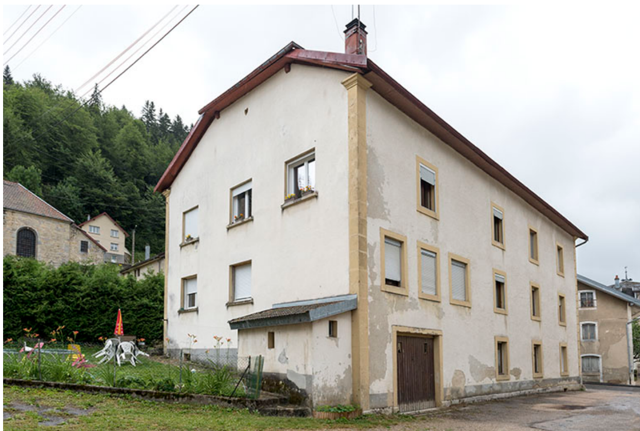
Façades postérieure et latérale gauche.
