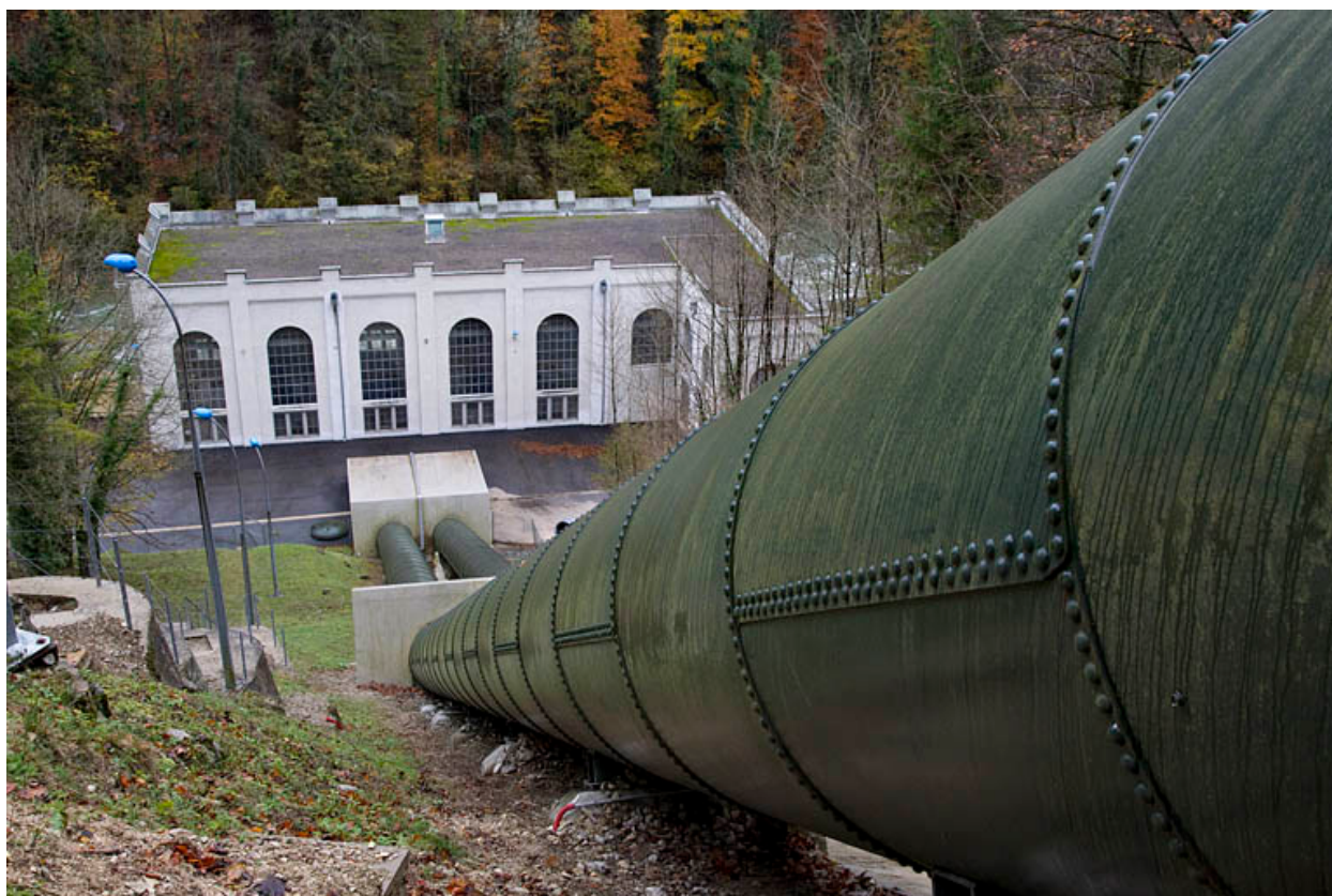
Conduite forcée : vue plongeante.
