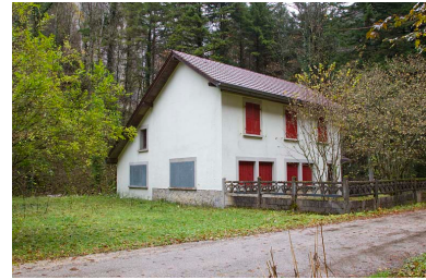
Ancienne école, vue de trois quarts gauche.
