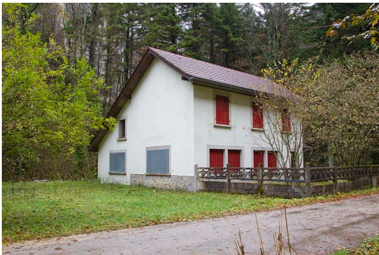
Ancienne école, vue de trois quarts gauche.
