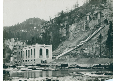
[Centrale en construction, vue de l'aval], [1908 ou 1909].
