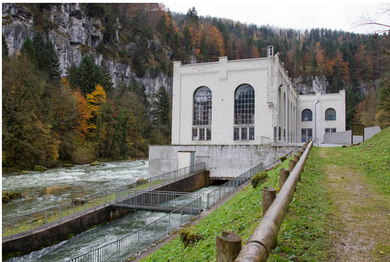
Centrale : façade postérieure (aval).
