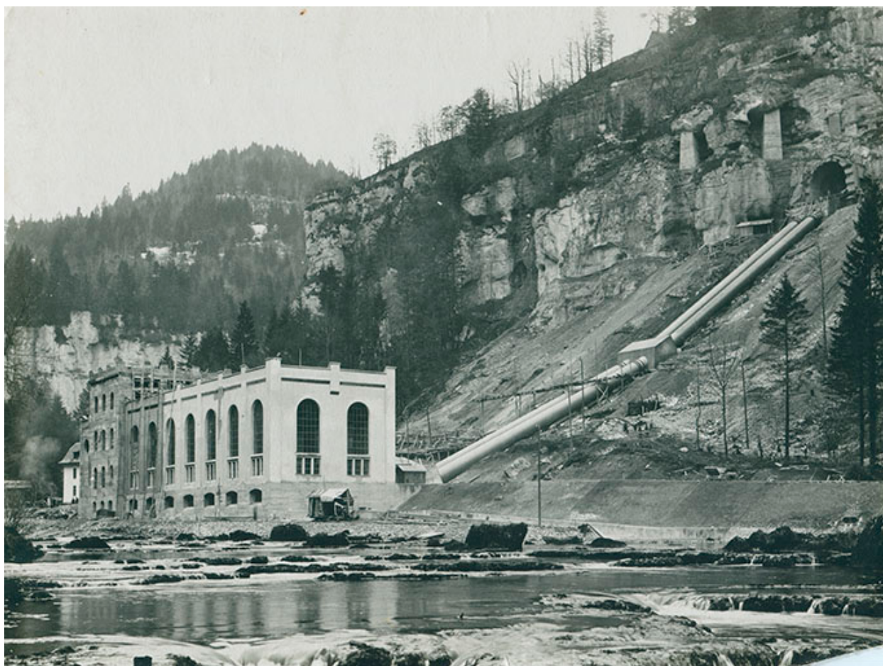
[Centrale en construction, vue de l'aval], [1908 ou 1909].
