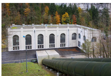
Centrale : façade latérale droite (élévation orientale). Phot. Yves Sancey IVR43_20122502153NUC2A
