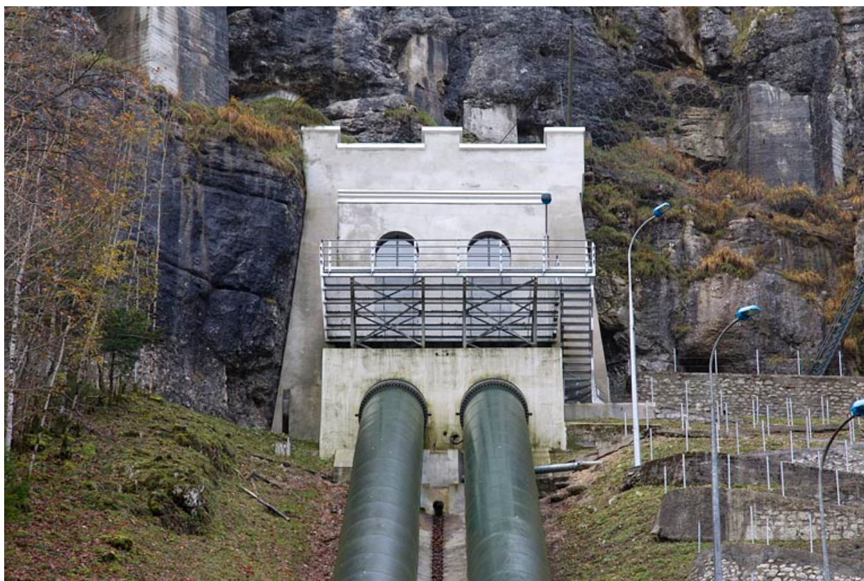
Conduite forcée : chambre de mise en charge.
