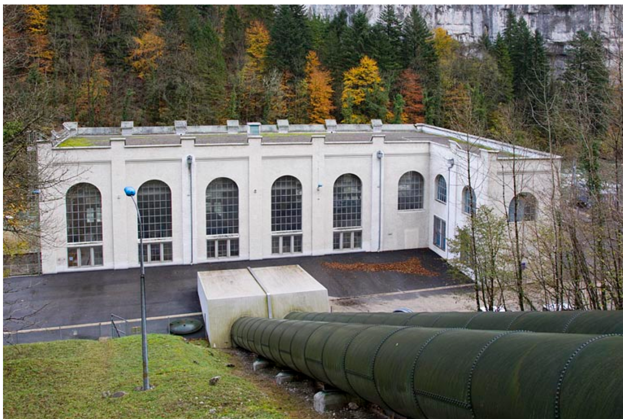
Centrale : façade latérale droite (élévation orientale).
