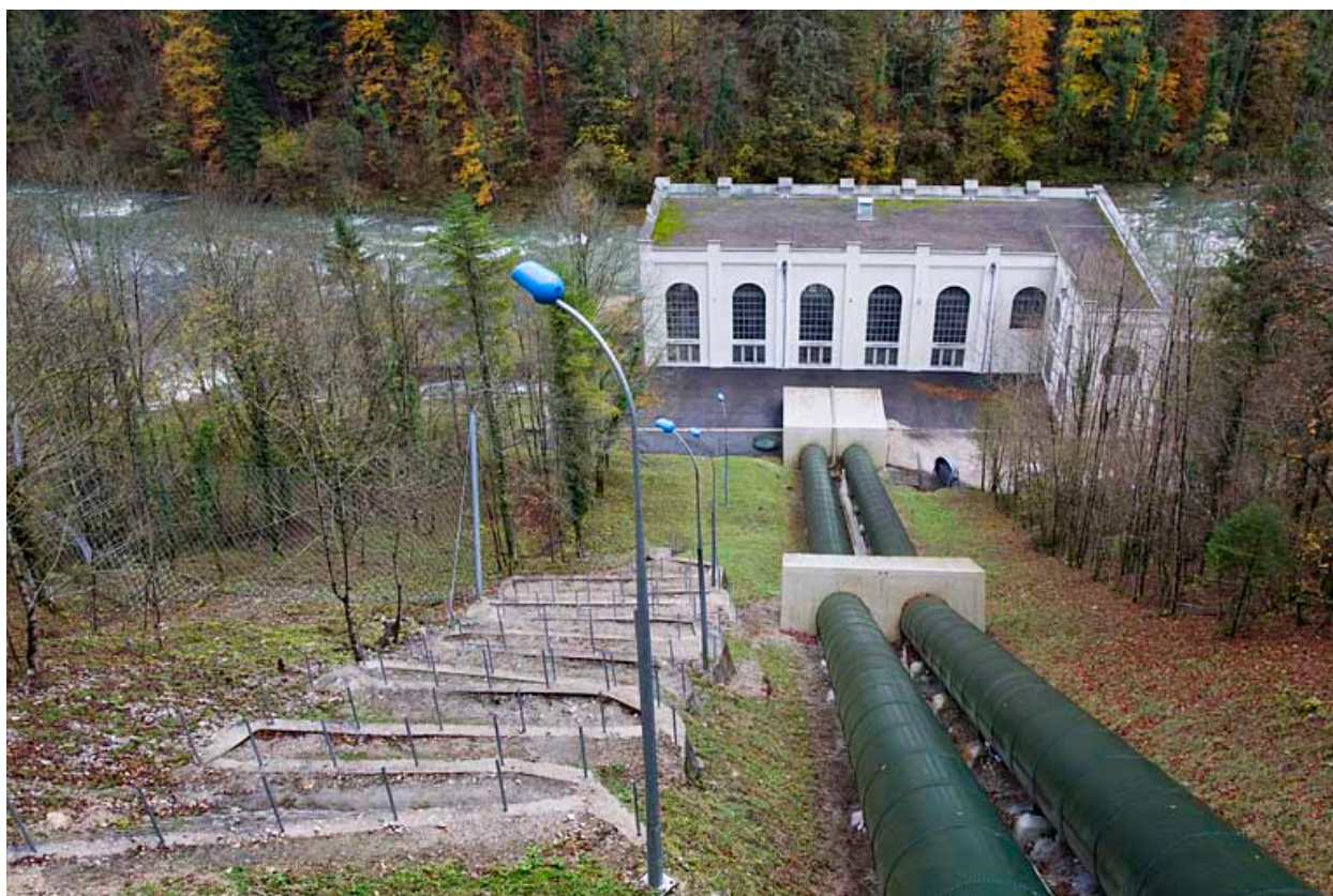
Centrale : vue plongeante depuis l'ouest.
