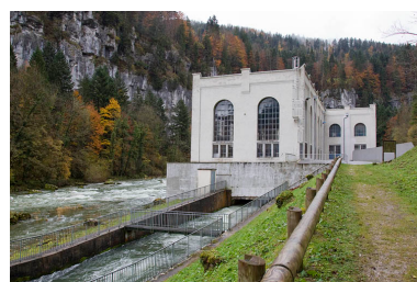
Centrale : façade postérieure (aval). Phot. Yves Sancey IVR43_20122502156NUC2A
