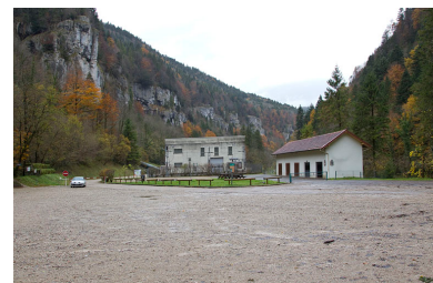
Vue d'ensemble, depuis le sud (amont). Phot. Yves Sancey IVR43_20122502160NUC2A
