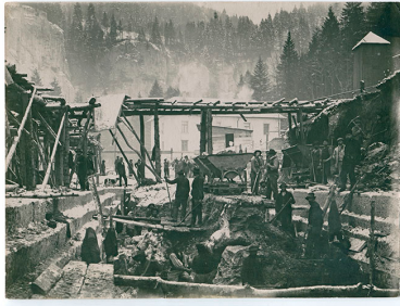
[Creusement de la chambre d'eau], [1907 ou 1908].
