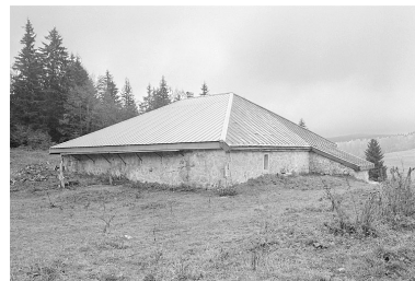
Angle nord-ouest. Phot. Jérôme Mongreville IVR43_19963901482X
