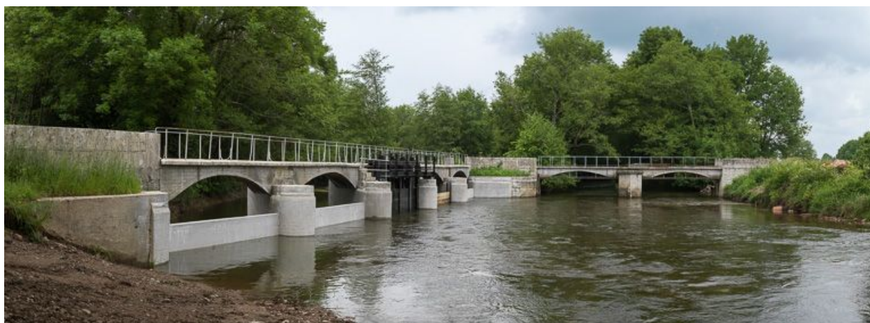
Corbigny, barrage de prise d'eau sur l'Yonne.
