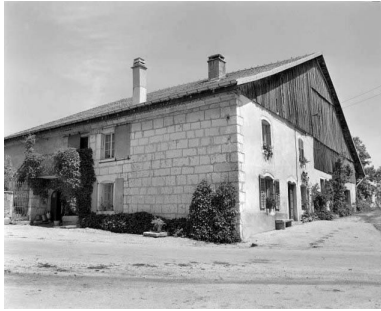
Facades antérieure et latérale gauche. Phot. Yves Sancey IVR43_19782500169X
