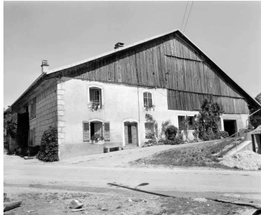
Pignon antérieur. Phot. Yves Sancey IVR43_19782500168X
