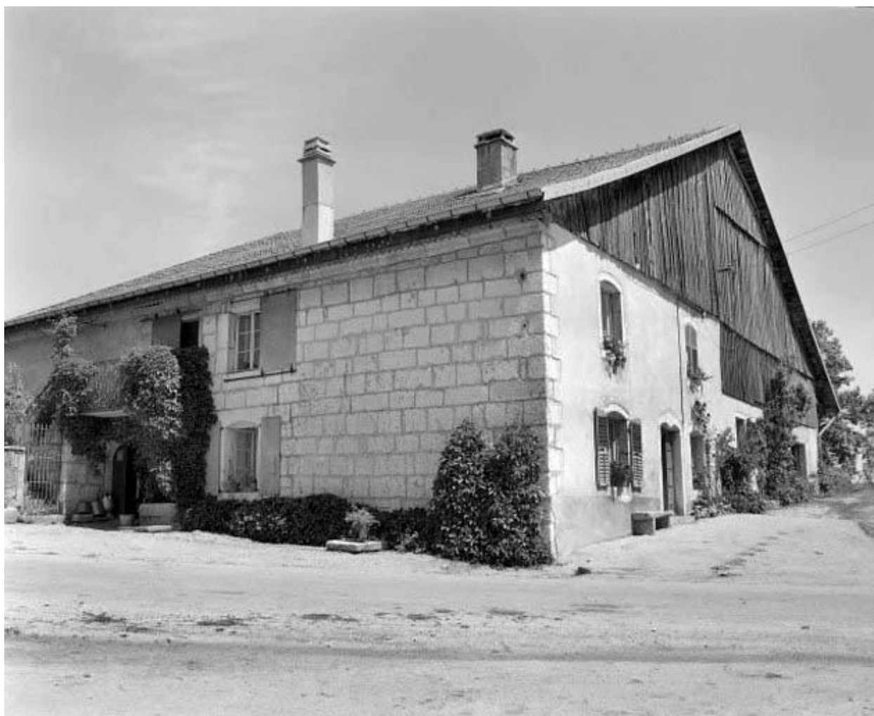
Facades antérieure et latérale gauche.
