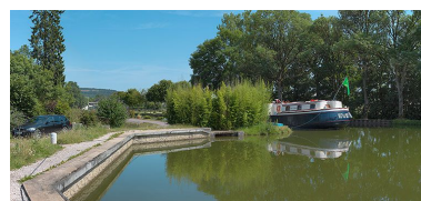
Déversoir du port rive gauche. Phot. Thierry Kuntz IVR26_20122102058NUC4AQ
