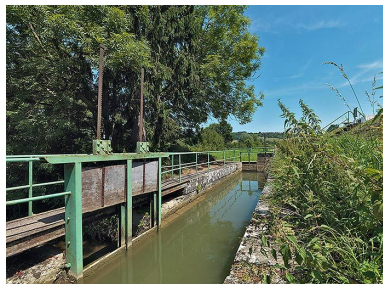
Vannes de régulation sur la rigole. Phot. Thierry Kuntz IVR26_20122102078NUC4A
