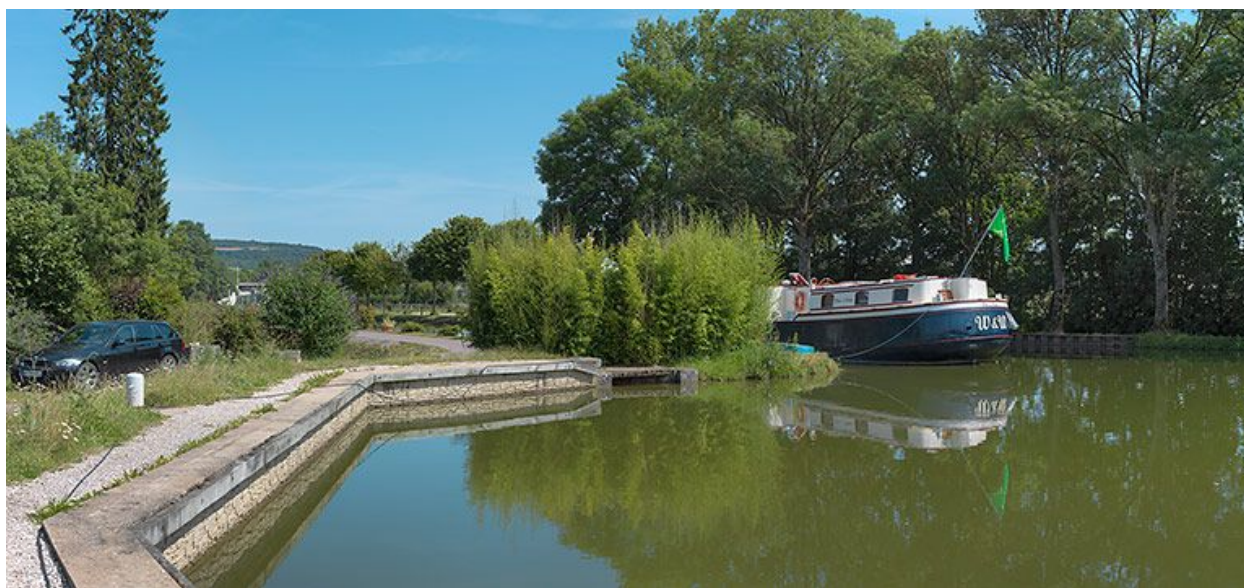
Déversoir du port rive gauche.
