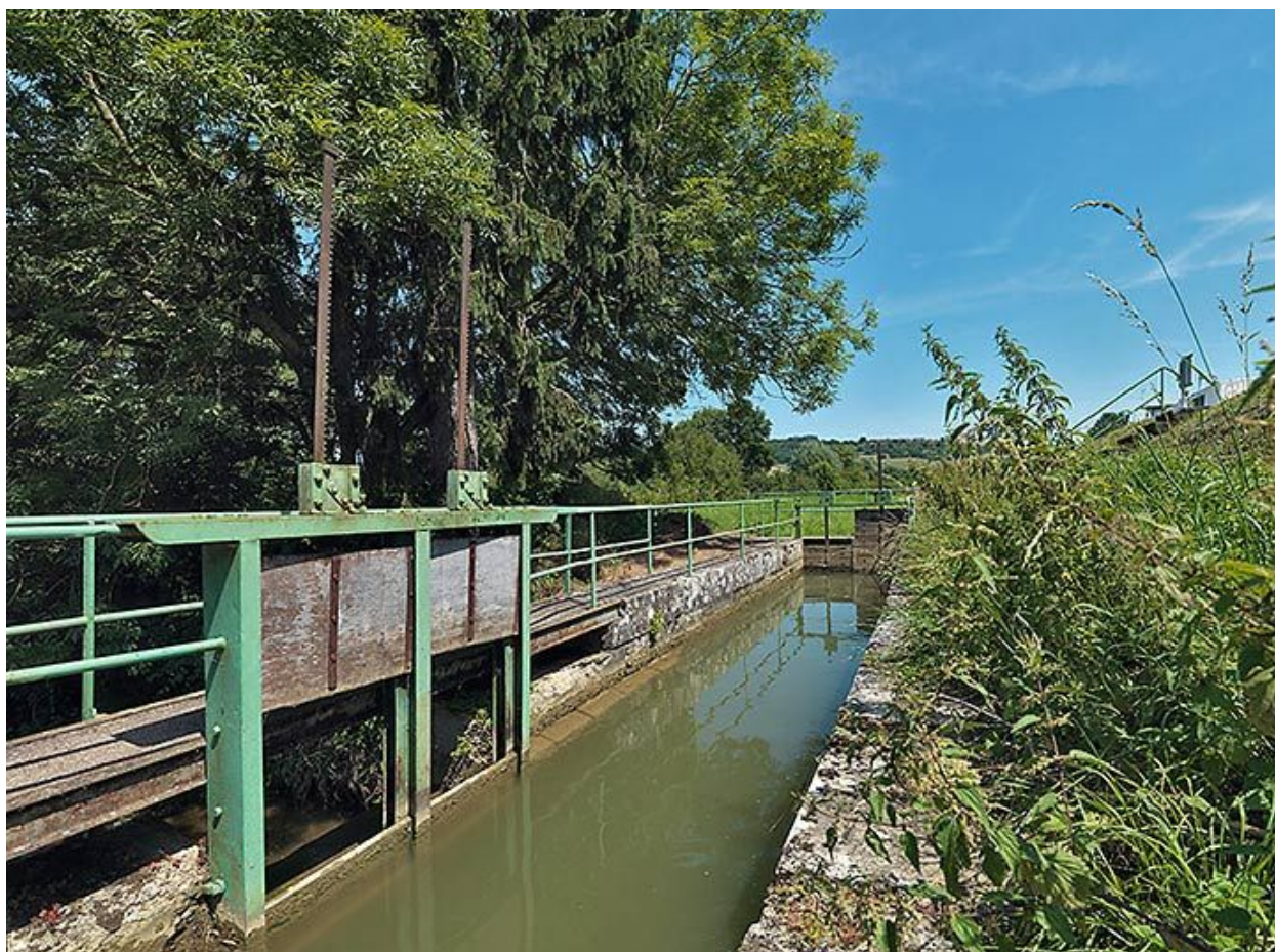
Vannes de régulation sur la rigole.
