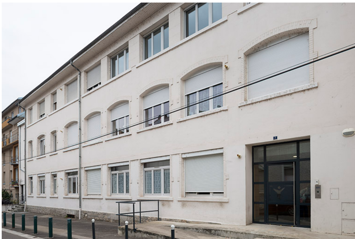
Façade de l'atelier (n°5 et 7).
