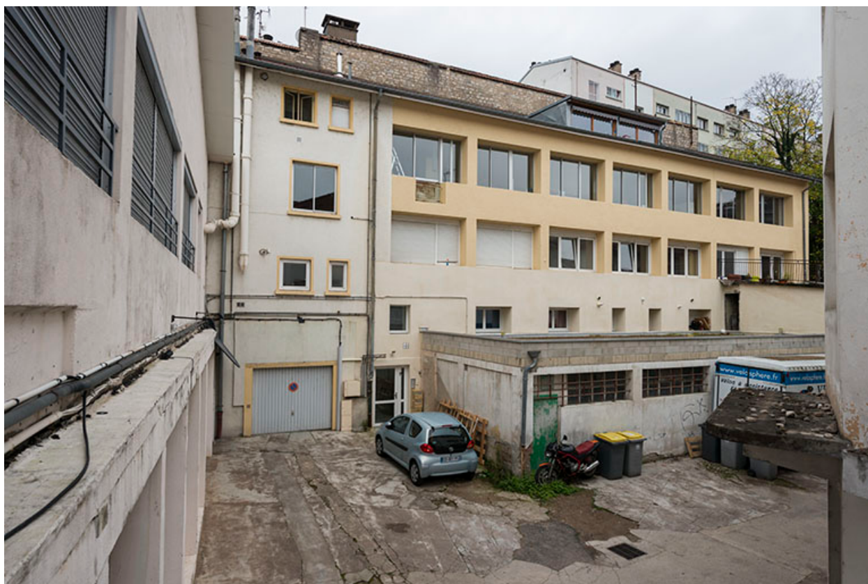
Façade ouest d'un atelier sur cour (4B).
