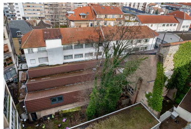
Vue plongeante depuis le sud. Phot. Jérôme Mongreville IVR43_20192500130NUC4A
