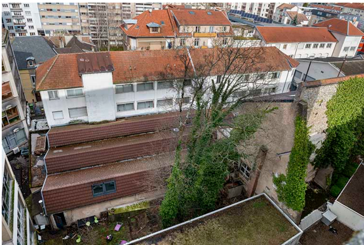
Vue plongeante depuis le sud.
