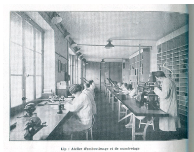
Lip : atelier d'emboutissage et de numérotage, 1933. IVR43_20162500574NUC2A
