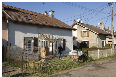
Façade est d'une maison. Phot. Jérôme Mongreville IVR43_20067000983NUCA
