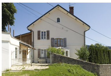
Façade latérale gauche. Phot. Jérôme Mongreville IVR43_20092500968NUC2A
