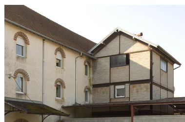
Tour du monte-charge (?). Phot. Jérôme Mongreville IVR43_20097000596NUC2A
