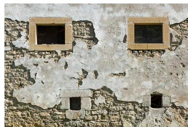
Moulin : fenêtres sur la façade ouest. Phot. Sonia Dourlot IVR43_20172501652NUC4A
