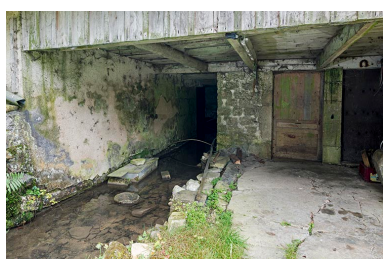
Moulin : canal de fuite sous le bâtiment (façade nord). Phot. Sonia Dourlot IVR43_20172501650NUC4A
