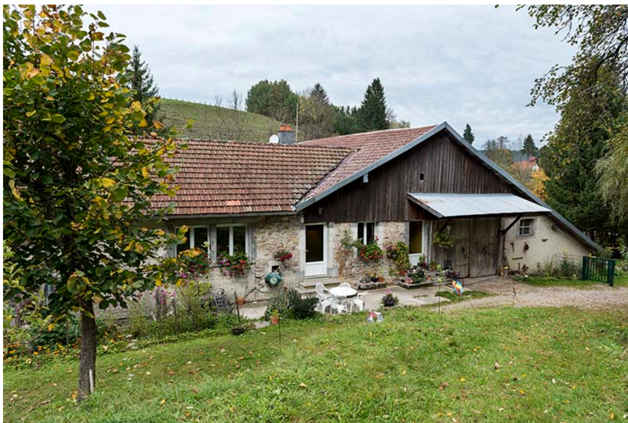
Moulin et logement : façade est.
