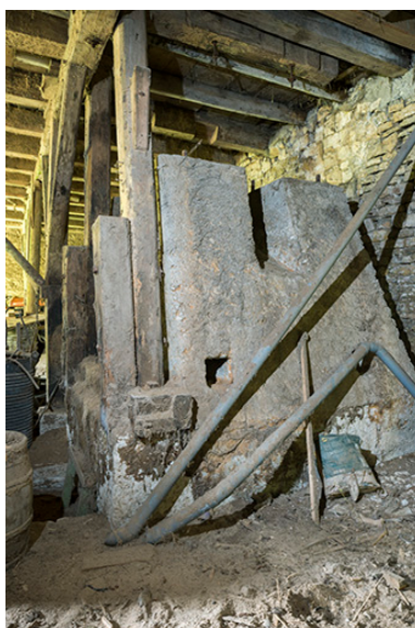
Scierie : socle en maçonnerie d'un châssis de scie. Phot. Sonia Dourlot IVR43_20172501651NUC4A
