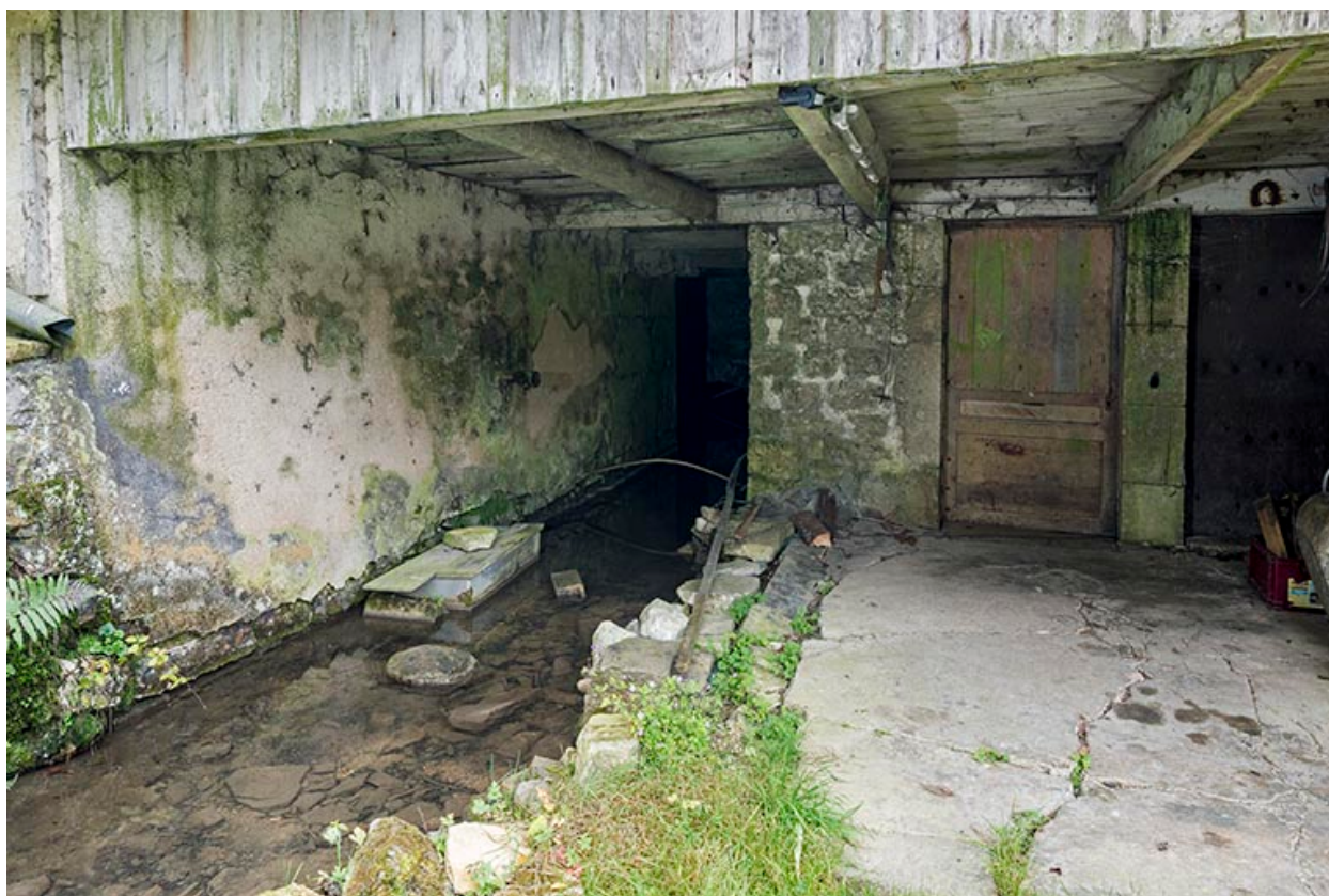
Moulin : canal de fuite sous le bâtiment (façade nord).
