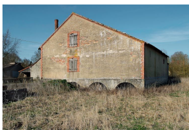
Bâtiment annexe au moulin principal, à usage d'entrepôt, construit sur arcades.
