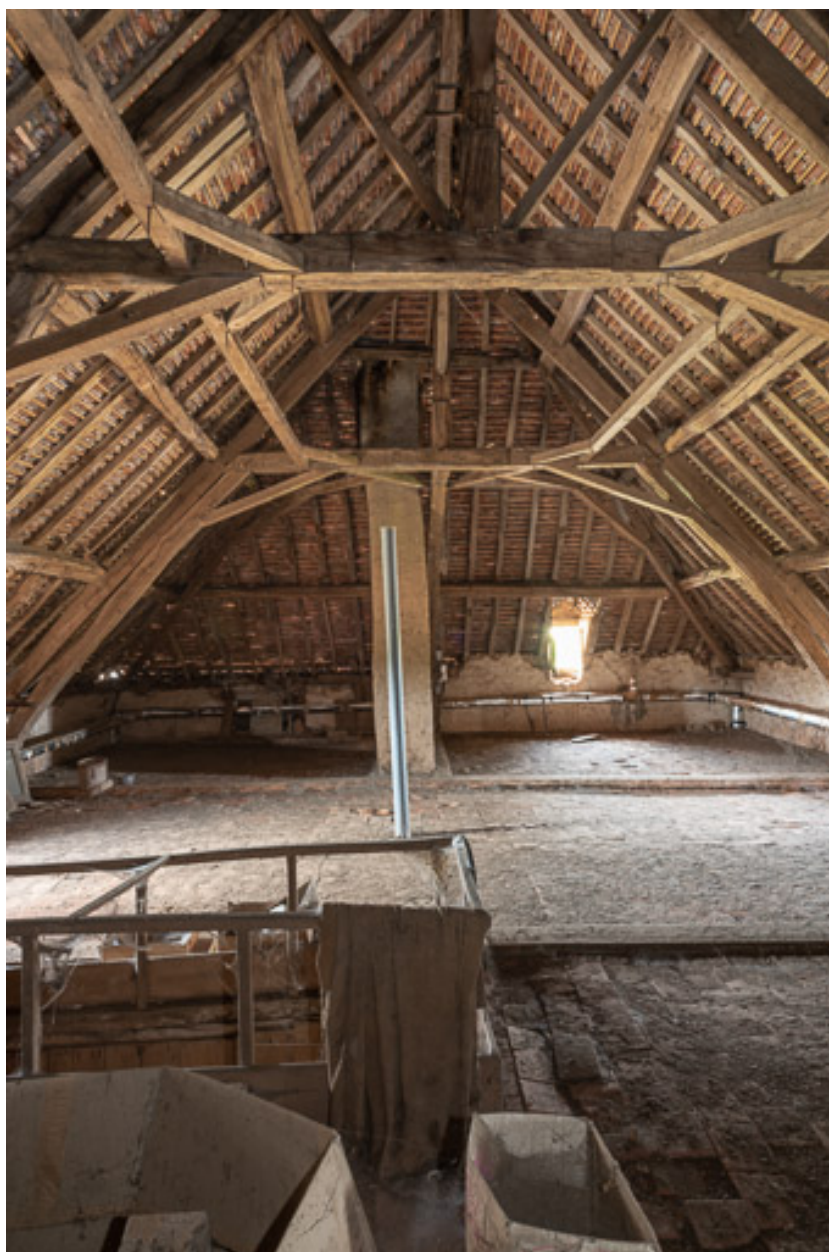
Vue de la charpente de la demeure
