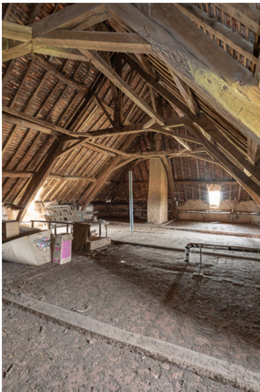
Vue de la charpente de la demeure
