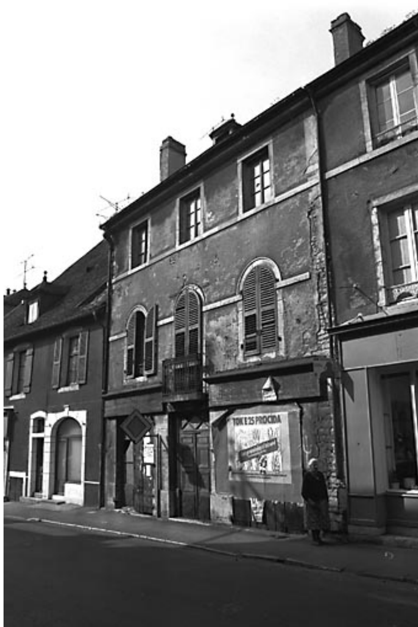
Façade antérieure avec magasins au rez-de-chaussée.
